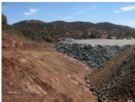
Desmatação confinada a zona autorizada (Agosto 2009)
