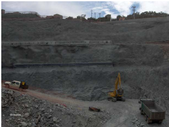
Escavação na Ensecadeira de Jusante. (Agosto de 2009)
