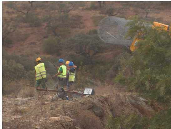
Colocação de vedações (Setembro 2009)
