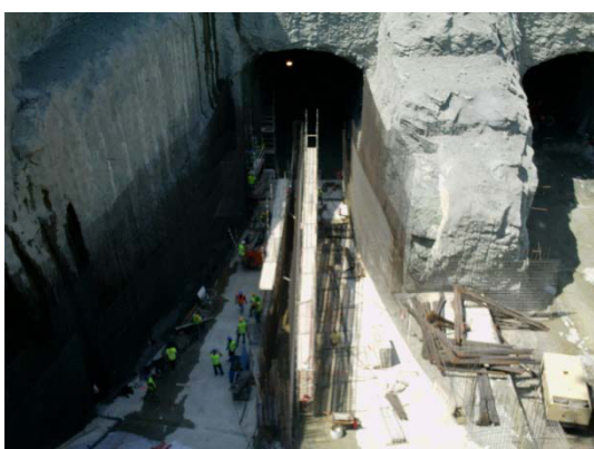
Contenção de taludes. Central. (Julho 2010)
