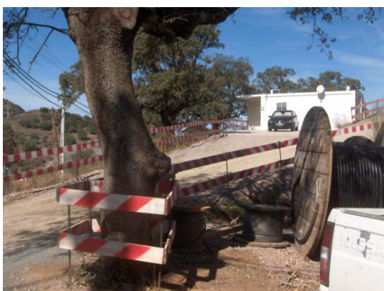
Vedações de protecção a árvores (Outubro 2009)
