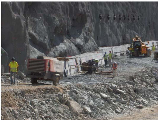
Contenção de taludes. Central. (Agosto 2009)
