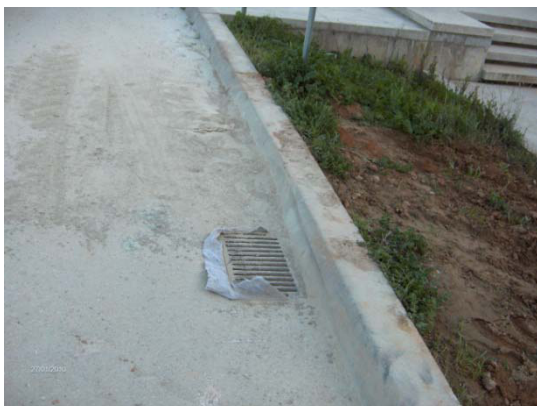
Sarjeta revestida a geotêxtil. Ensecadeira de montante (Janeiro 2010)
