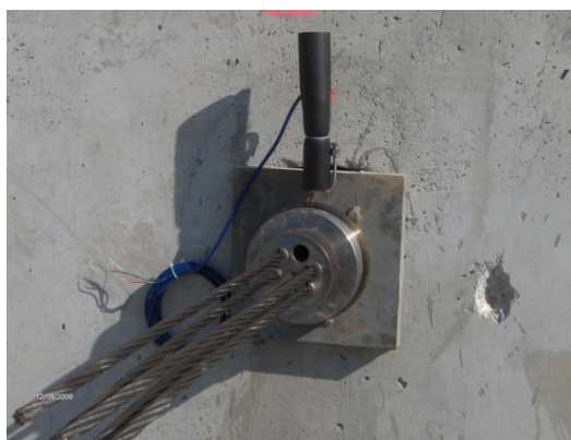
Contenção de taludes. Pormenor. (Agosto 2009)
