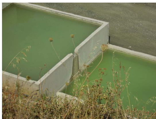
Tanques de decantação dos efluentes da escavação subterrânea (Julho 2010)
