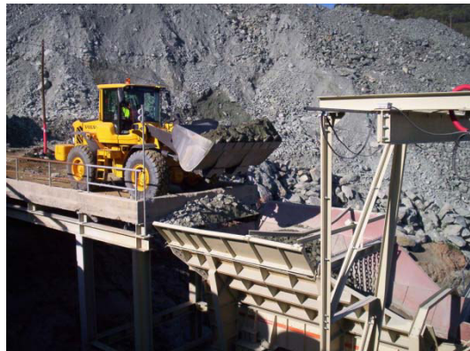
Central de Britagem, Reutilização do material escavado (Janeiro 2010)
