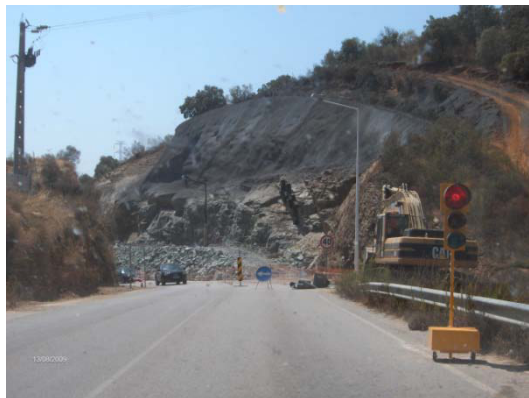
Sinalização. Intervenção na ER255 (Agosto 2009)
