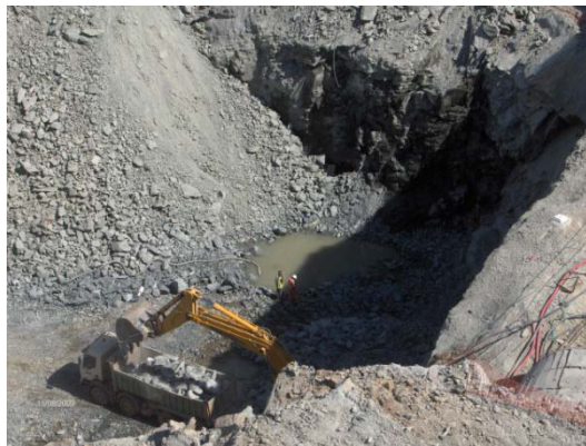
Escavação na Ensecadeira de Jusante. (Agosto de 2009)
