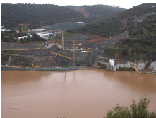
Contenção de taludes. Vista geral da Central. (Janeiro 2010)
