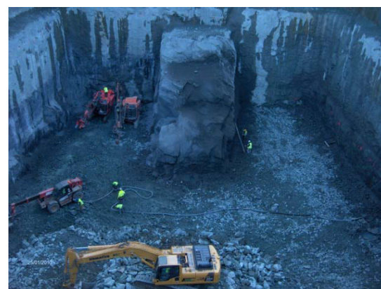
Escavação na Ensecadeira de montante. (Janeiro 2010)
