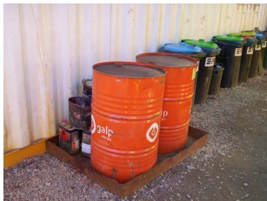
Bacia de retenção de substâncias perigosas. Estaleiro do Fornecedor de Equipamentos (Janeiro 2010)
