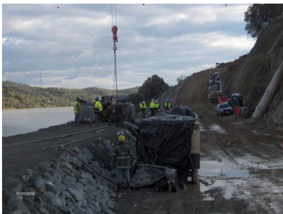
WC em frente de obra. Ensecadeira de montante (Janeiro 2010)
