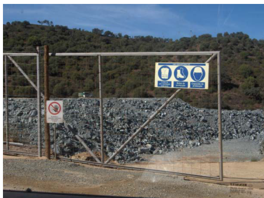
Sinalização de estaleiro (Outubro 2009)
