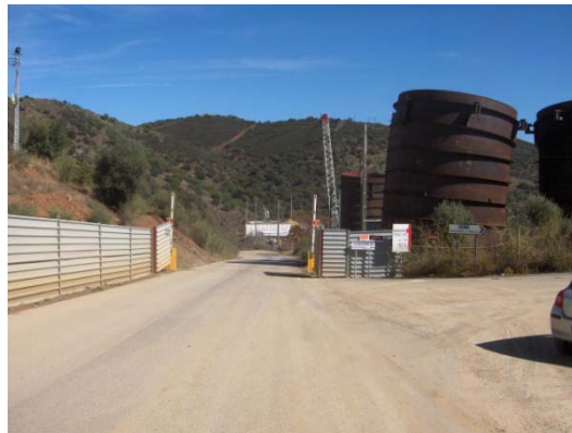
Sinalização de estaleiro (Outubro 2009)
