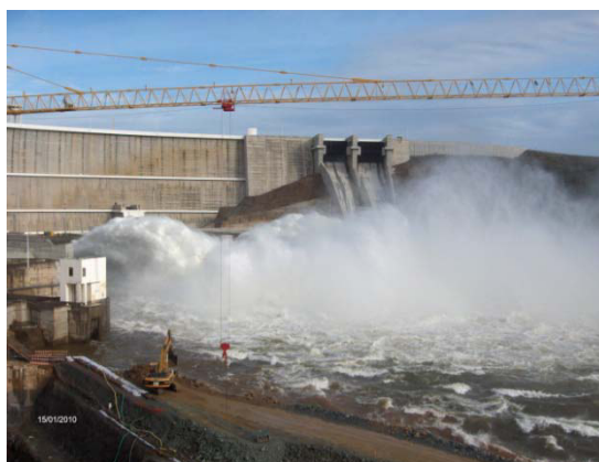
Escavação. Ensecadeira de montante (Janeiro de 2010)
