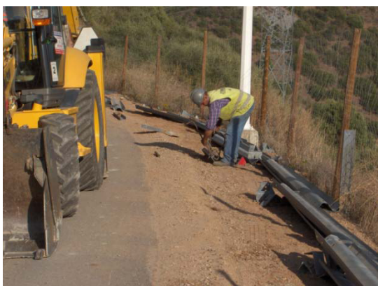
Vedações do estaleiro do Fornecedor de Equipamentos (Outubro 2009)
