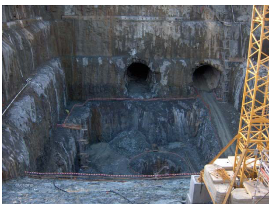
Escavação. Central (Janeiro de 2010)
