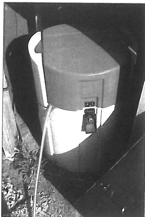
Foto 2 – Colocação do Amostrador para recolha da Amostra Composta (ETAR) (Arquivo fotográfico da obra)
