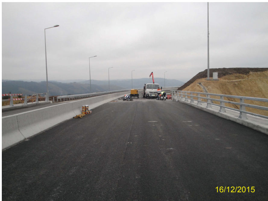
Registo Fotográfico 7 – Execução de Juntas de Dilatação (PS11A), junto ao Pk 29+300
