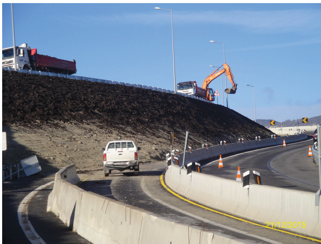
Registo Fotográfico 3 – Colocação terra vegetal em taludes – Nó Parada Cunhos
