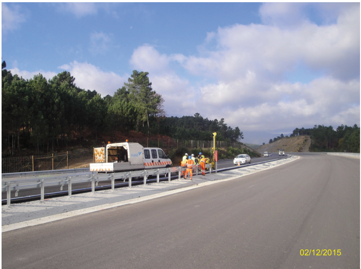
Registo Fotográfico 1 – Execução de guardas de segurança junto ao Pk 24+200
