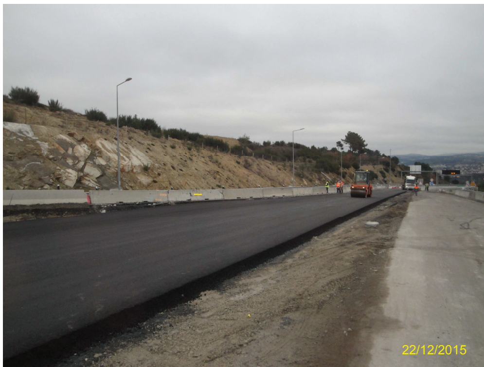
Registo Fotográfico 4 – Execução de Pavimentação junto ao Pk 29+500
