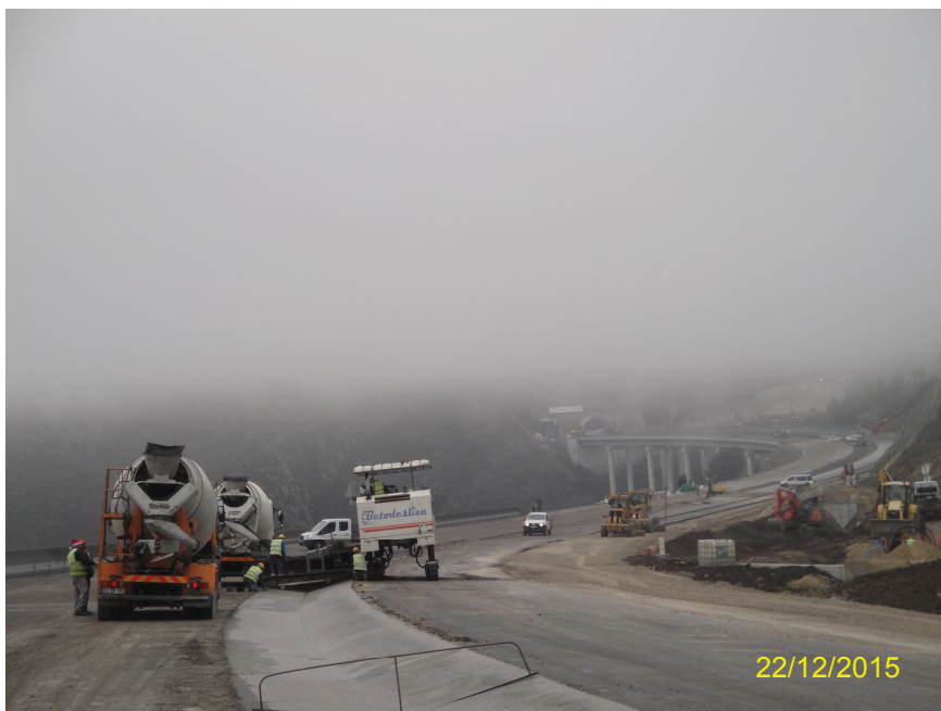
Registo Fotográfico 6 – Execução de valetas de plataforma junto ao Pk 20+600
