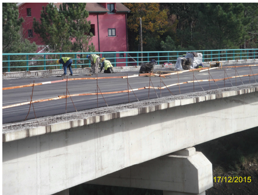
Registo Fotográfico 8 – Montagem de Vigas (V10), junto ao Pk 19+800
