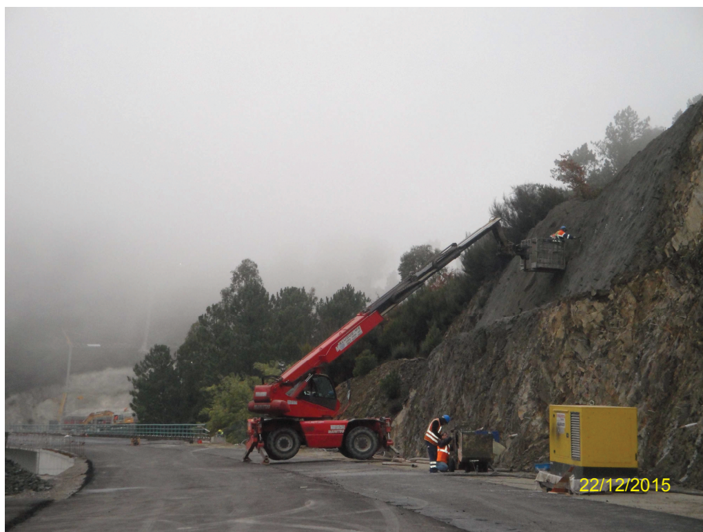
Registo Fotográfico 5 – Execução de betão projectado junto ao Pk 20+000
