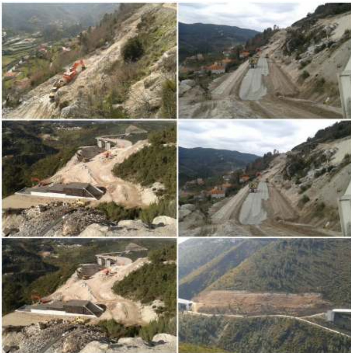
Fotos n.º7 a 12 - Obra Geral - Atividades de terraplenagem
