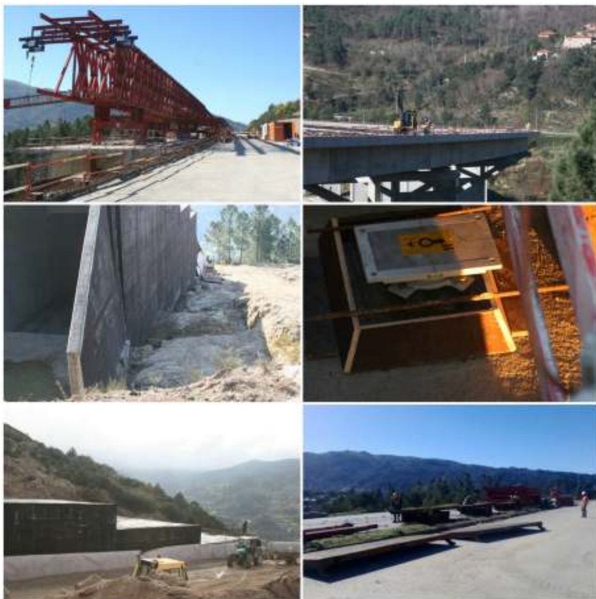
Fotos n.º13 a 18 - Obras de arte - Atividades diversas
