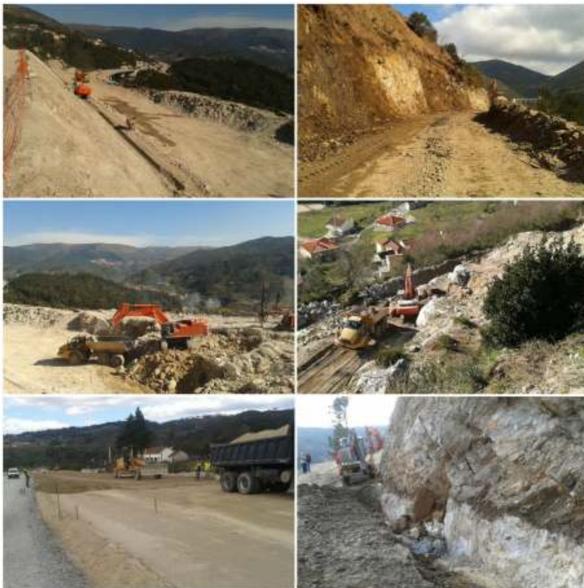
Fotos n.º1 a 6 - Obra Geral - Atividades de terraplenagem
