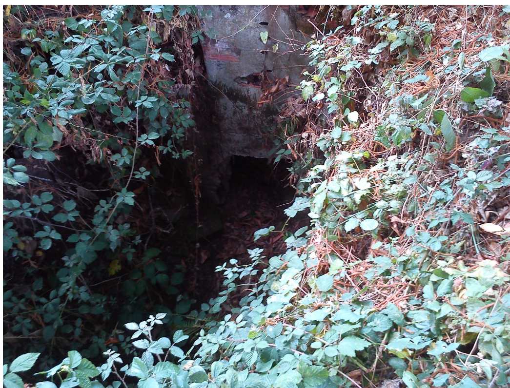
Foto: estado do ponto SUB28
