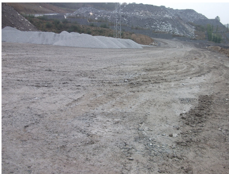
Figura 1- Aspeto inicial da área de instalação da central
