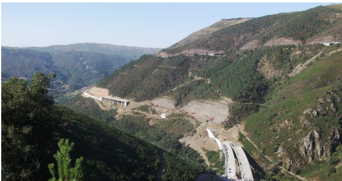
Figura 3. Panorâmica da obra
