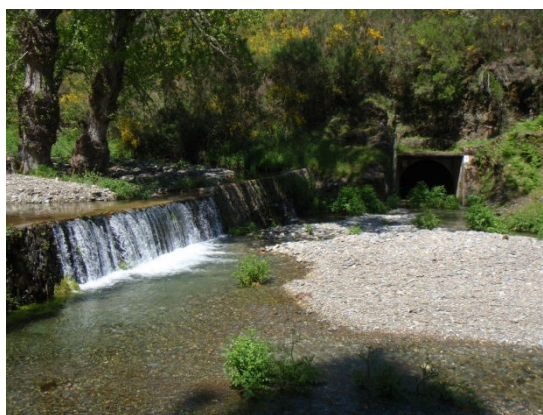
Figura 9 – Castanheira-Tojo (APS11): vista da entrada do túnel e área envolvente, no Açude de Castanheira
