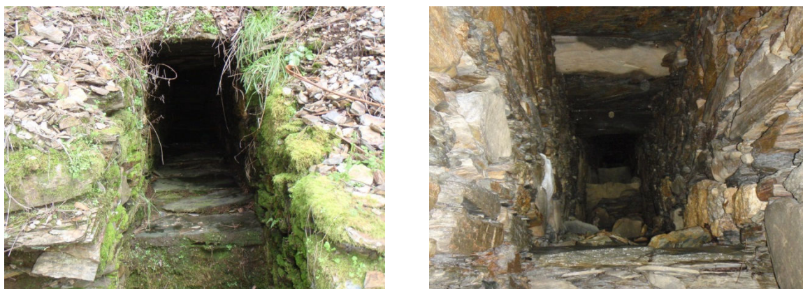
Figura 8 – Coladinha III (APS10): vistas da entrada e do interior do túnel
