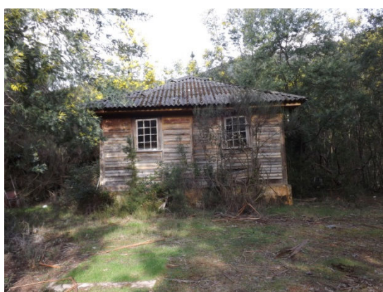
Figura 7 – Abrigo nº 58 (Coladinha): vista exterior da casa
