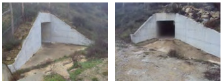
Local de monitorização S1M e S1J
