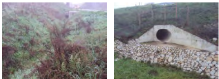
Local de monitorização S2M e S2J
