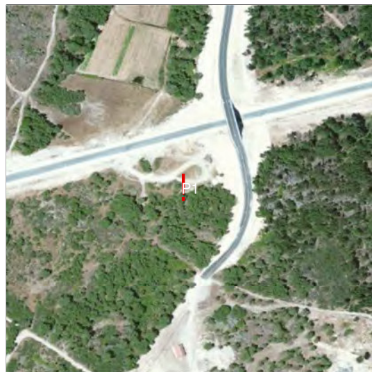
Local de monitorização P1
