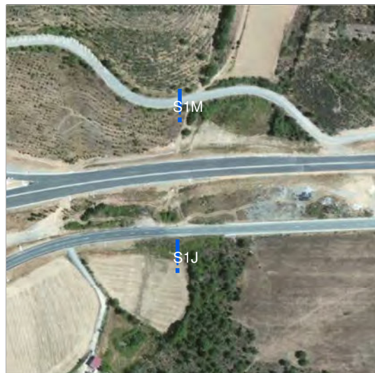
Local de monitorização S1
