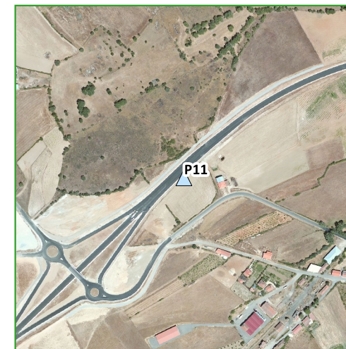
P11 - Poço ao km 34+510
