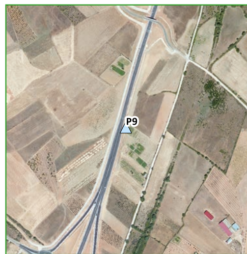
P9 - Poço ao km 23+900
