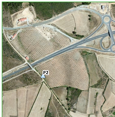
P2 - Poço ao km 0+250
