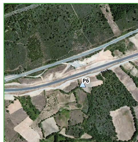
P6 - Poço ao km 6+050
