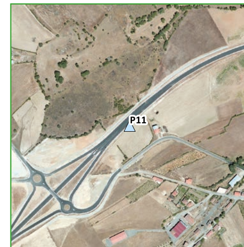
P11 - Poço ao km 34+510
