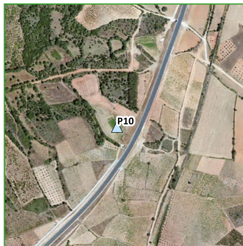
P10 - Poço ao km 29+325
