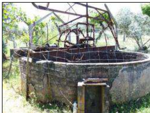
Figura 3. 1 – Ponto de recolha P0 – Poço
