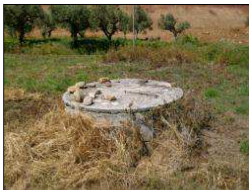
Figura 3.7 – Ponto de recolha P6 – Poço
