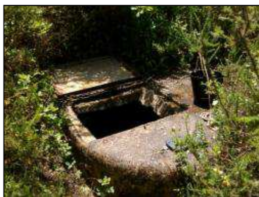
Figura 3. 2 – Ponto de recolha P1 – Poço
