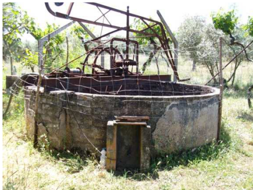
Figura 3. 1 – Ponto de recolha P0 – Poço
