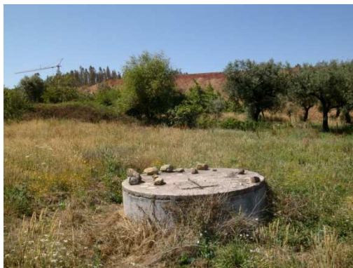
Figura 3.7 – Ponto de recolha P6 – Poço
