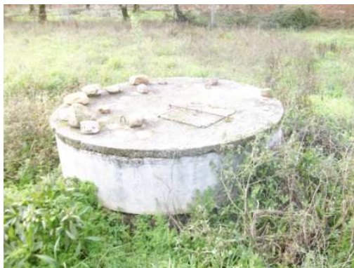
Figura 3.7 – Ponto de recolha P6 – Poço
