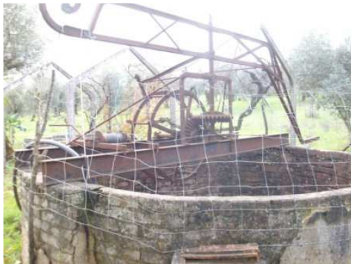
Figura 3. 1 – Ponto de recolha P0 – Poço
