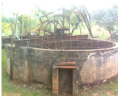
Figura 3. 6 – Ponto de recolha P0 – Poço
