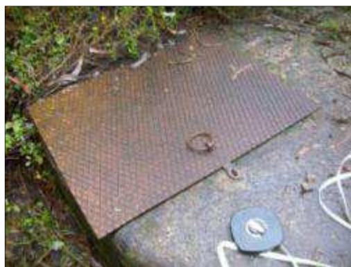
Figura 3. 2 – Ponto de recolha P1 – Poço
