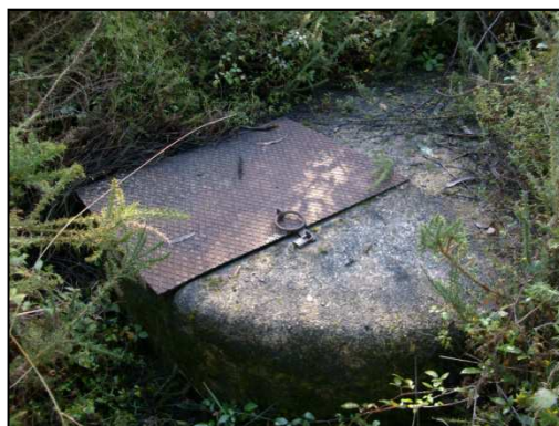
Figura 3. 1 – Ponto de recolha P1 – Poço
