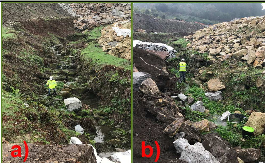
Figura 2: Segmento da Ribeira da Fonte Fria, onde foram executados os trabalhos de captura de anfíbios. a) – Aspeto do segmento a jusante na área de intervenção; b) – Aspeto a montante da zona de atuação
