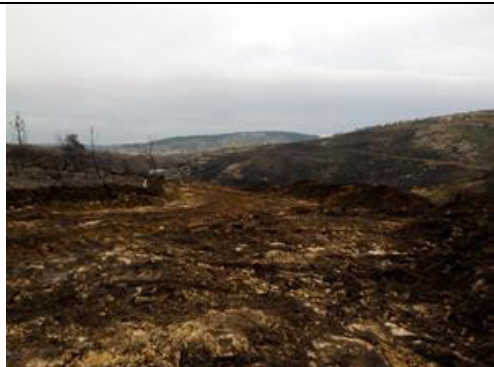
Figura 3 – Execução de acesso não previsto em RECAPE
