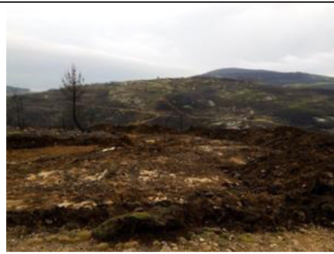
Figura 4 – Execução de acesso não previsto em RECAPE
