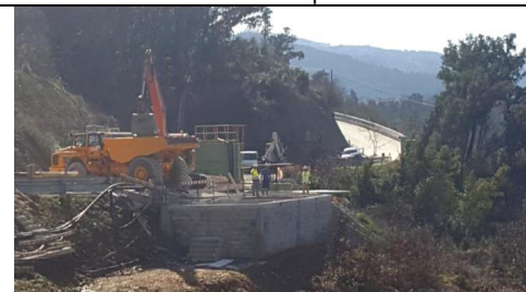
Figura 8 – Limpeza das bacias de decantação da ETAL associada ao ponto de descarga PV1
