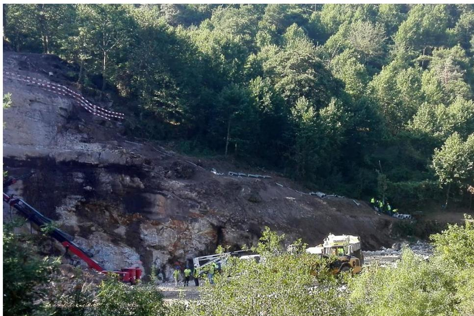
SET| Instalação de manilhas meia-cana na vala de crista, na boca de saída do túnel.
