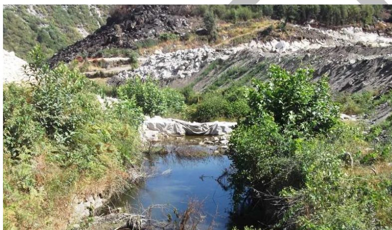
Figura 1 – Adoção de medidas mitigadoras de contaminação físico-química da água (e.g. barreira de enrocamento e geotêxtil na linha de água).
