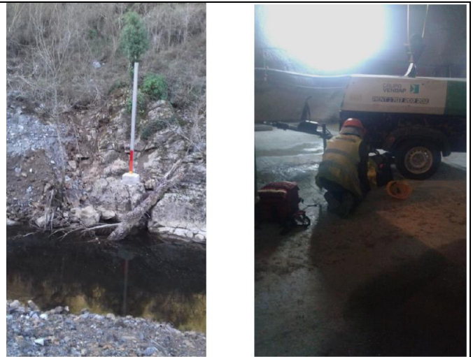
Figura 4 – Realização de simulacro de Cheia realizado na frente de trabalho do túnel de desvio do rio do Alto Tâmega (08/01/2017)
