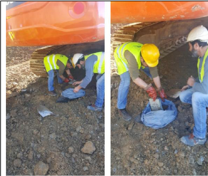
Figura 3 – Realização de simulacro Derrame de substância perigosa com risco de afectação da água do rio na Ensecadeira da Tomada de Água de Daivões (21/12/2017)
