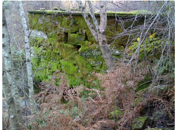
SET - Alçado oeste da estrutura, envolvida por vegetação.
