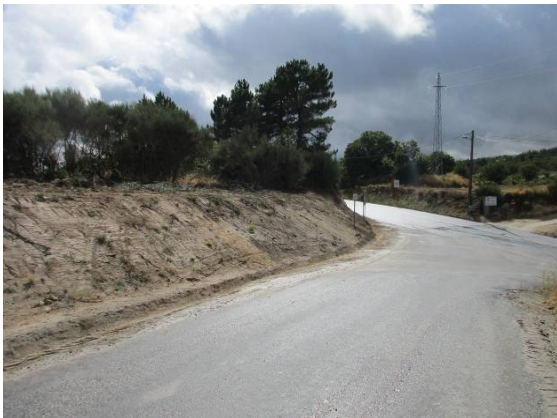
Fotografia 1 - Talude recuperado à entrada da via N1.
