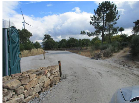
Fotografia 2 - Muro de pedra seca reconstruído na via N1 e delineadores instalados.
