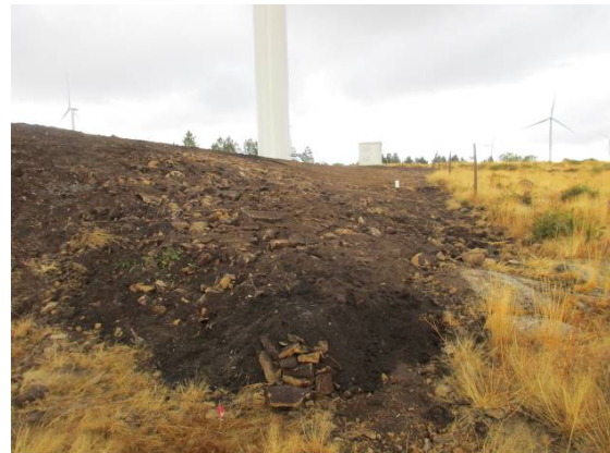
Fotografia 5 - Local onde foram executados e concluídos os trabalhos da drenagem da fundação do aerogerador AG13.
