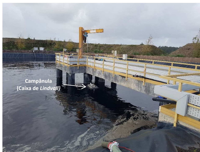
Figura 3.4 – Localização da caixa de Lindvall na bacia de lixiviados (P3).
