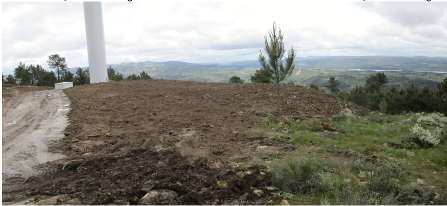
Fotografia 8 - Plataforma do aerogerador AG42 recuperada.
