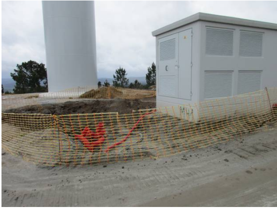
Fotografia 6 - Trabalhos elétricos no posto de transformação do aerogerador AG41.
