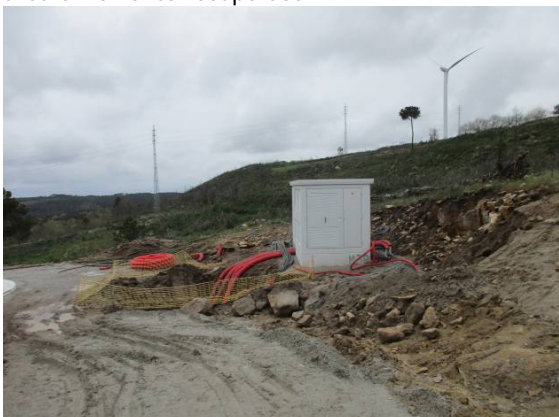
Fotografia 3 - Trabalhos elétricos no posto de transformação do aerogerador AG38.
