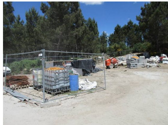
Fotografia 10 - Área de apoio aos trabalhos no núcleo da Aldeia de Nacomba vedada e organizada por áreas funcionais.
