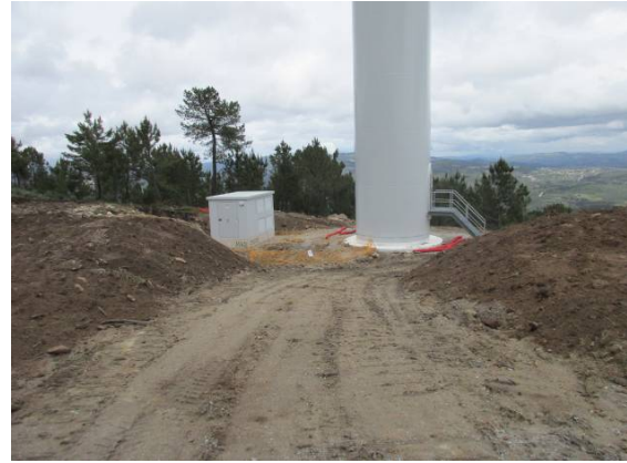
Fotografia 7 - Trabalhos elétricos no posto de transformação do aerogerador AG42.
