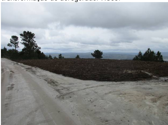
Fotografia 5 - Plataforma do aerogerador AG41 recuperada.
