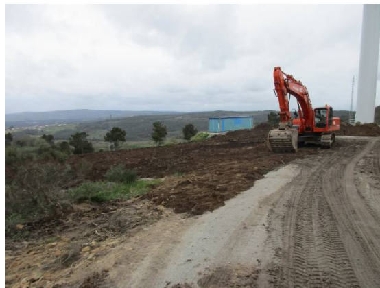
Fotografia 2 - Trabalhos de recuperação paisagística da plataforma do aerogerador AG38.
