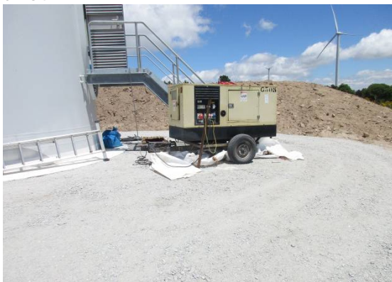
Fotografia 11 - Trabalhos de comissionamento de um aerogerador.
