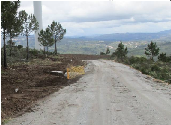
Fotografia 9 - Execução da caixa de visita de uma passagem hidráulica entre os aerogeradores AG41 e AG42.
