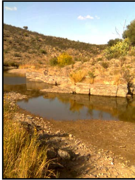
Ponte de Penilhos
