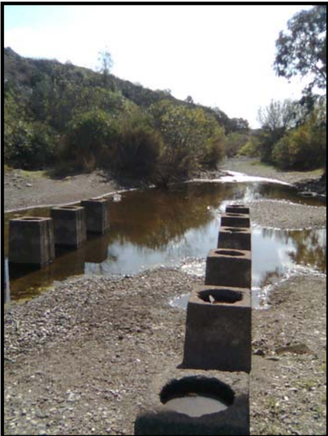
Ponte da Camacha
