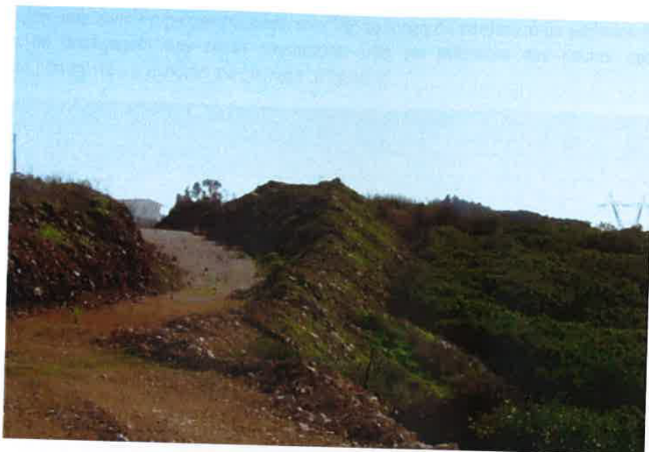
Figura 1- Evolução do aterro com cordões de terra ao longo da bordadura da pedreira
