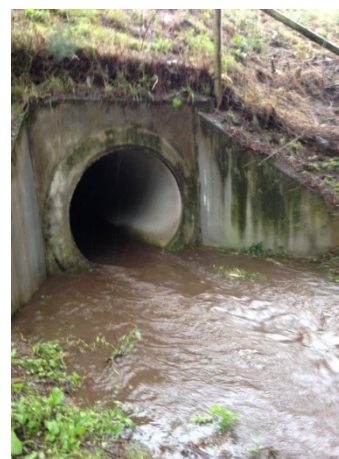
Figura 9 – Linha de água SUP1, no ponto de jusante, na amostragem do período crítico
