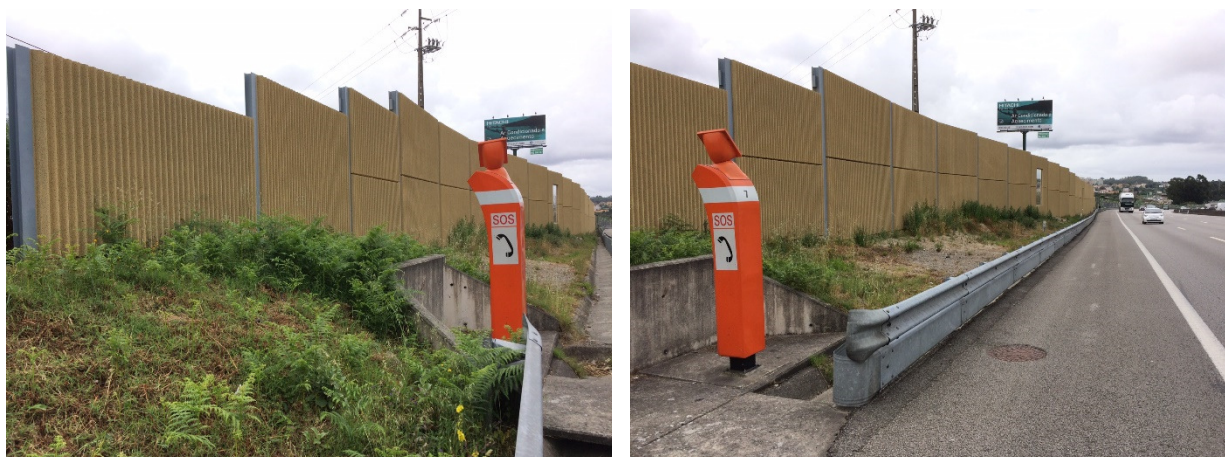
Figura 91 – Barreira acústica edificada para proteção do recetor R13 no Sublanço Águas Santas/Maia
