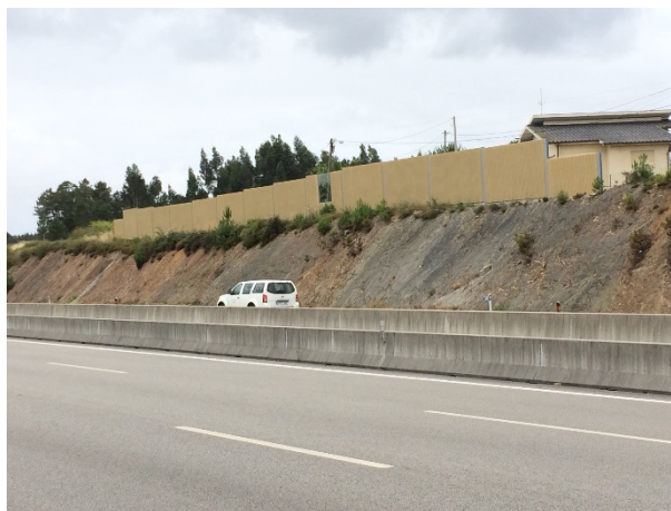
Figura 92 – Barreira acústica edificada para proteção do recetor R26 no Sublanço Maia/Santo Tirso
