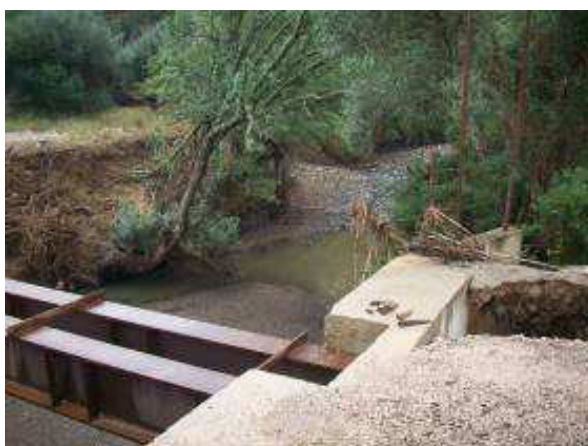
Fotografia 24 – Rio Arade – Jusante
