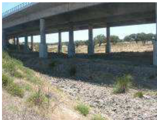
Fotografia 14 – Viaduto sobre a Ribeira da Pena Seca
