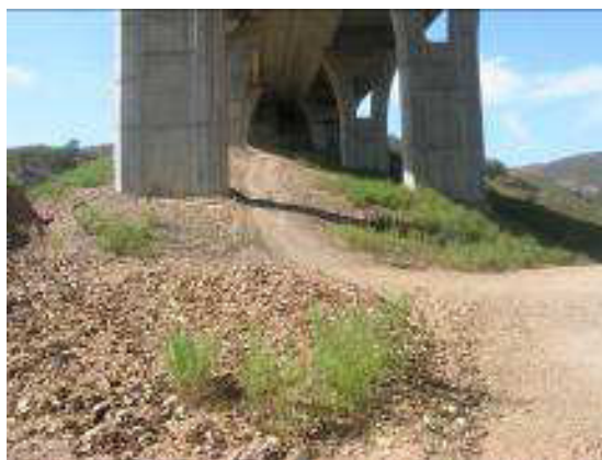
Fotografia 36 – Viaduto do Cerro da Barreira
