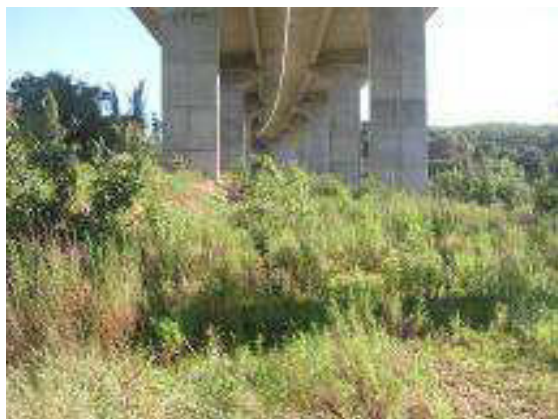
Fotografia 39 – Viaduto sobre a Ribeira do Gavião
