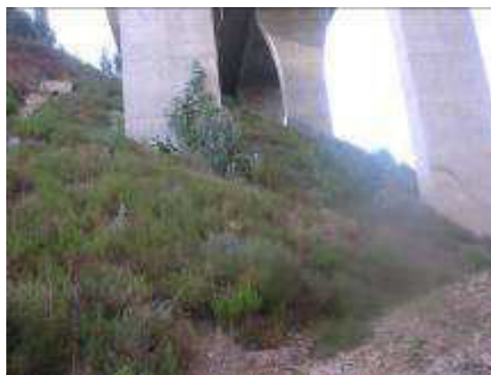
Fotografia 32 – Viaduto sobre o Barranco do Corte Amarelo
