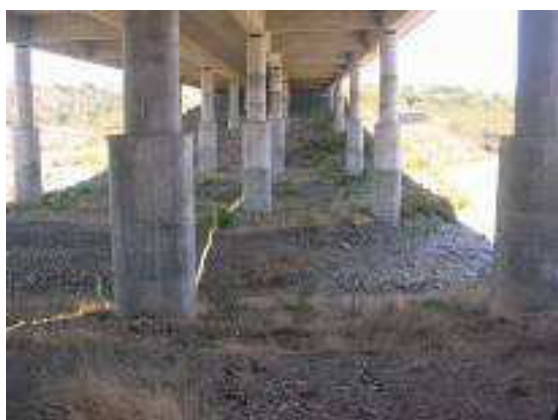
Fotografia 17 – Viaduto sobre a Ribeira de Mora
