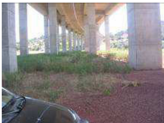
Fotografia 41 – Viaduto sobre o Barranco do Vale
