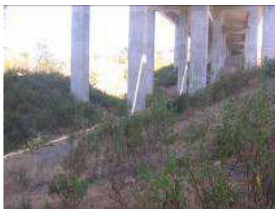
Fotografia 29 – Viaduto sobre o Barranco da Escombreira
