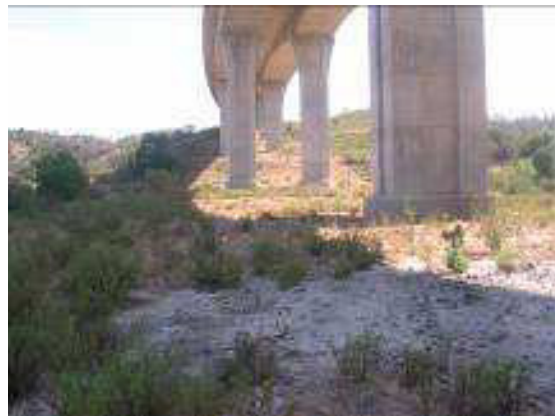
Fotografia 38 – Viaduto sobre o Rio Arade
