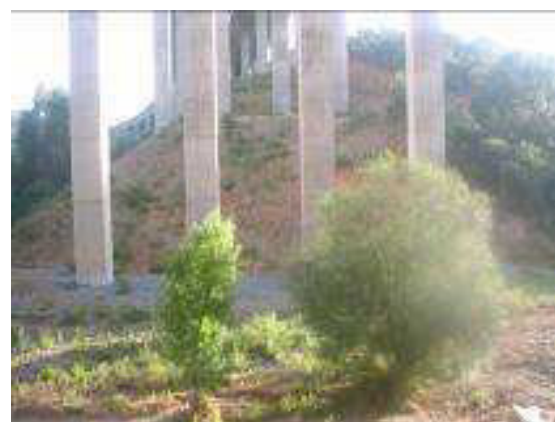
Fotografia 30 – Viaduto sobre a Ribeira da Azilheira
