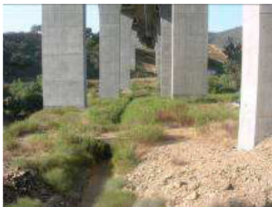
Fotografia 33 – Viaduto sobre a Ribeira de Odelouca
