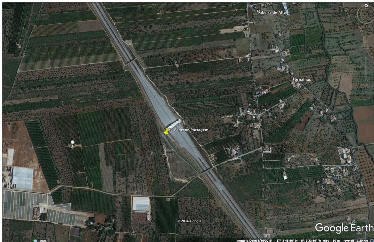
Figura 4 – Enquadramento espacial do local de medição em Paderne, A2 - Castro Verde/Almodôvar/S. Bartolomeu de Messines/A22 (adaptado de Google Earth ).
