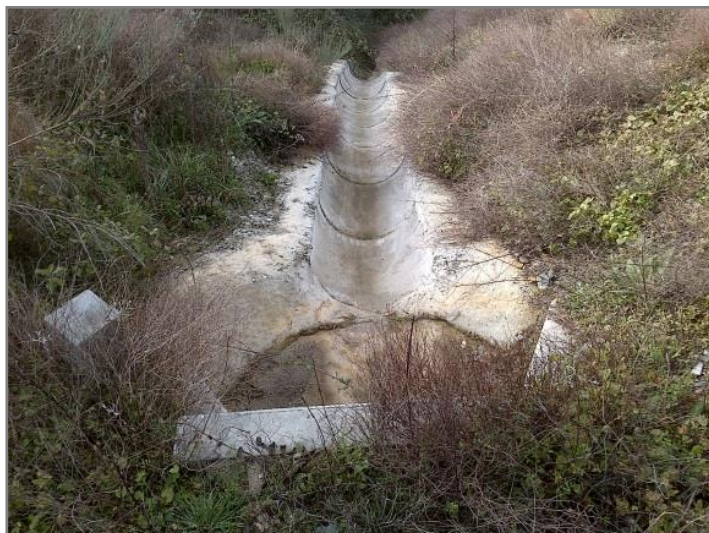
Figura 3.17 - Ponto de descarga das águas de escorrência da plataforma ao km 7+655 (PH 7-3).
