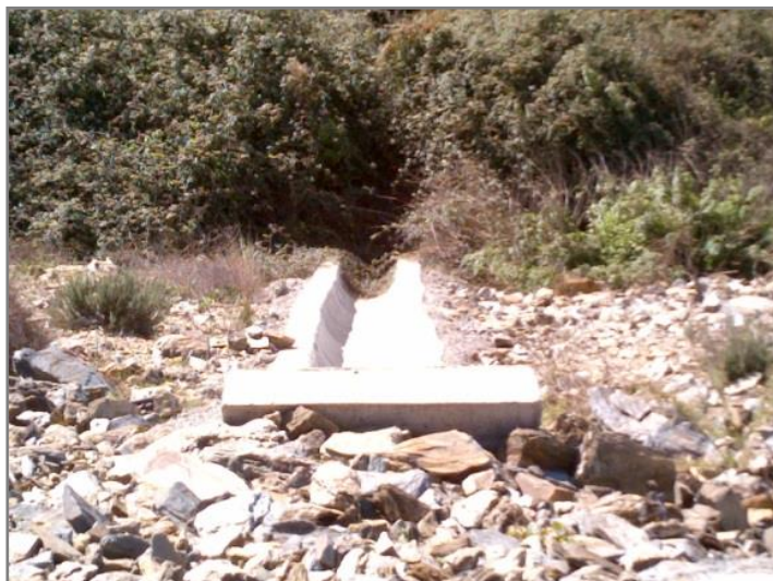
Figura 3.13 - Ponto de descarga das águas de escorrência da plataforma ao km 1+328 (PH 1-3).
