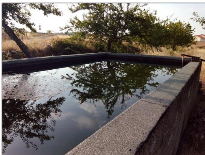
Figura 3.22 – P4, Tanque nº7, junto à Rotunda 1 do Ramo B, do lado direito da via.
