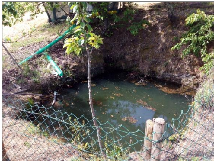
Figura 3.21 – P3, Poço nº 6, junto à Rotunda 2, do lado esquerdo da via.
