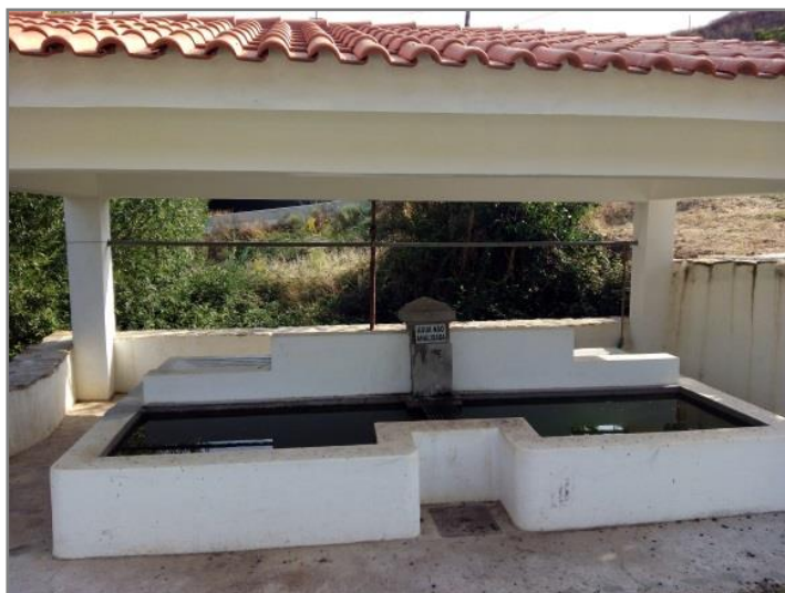
Figura 3.19 – P1, Captação Pública n.º 1, ao km 5+400, do lado direito da via.
