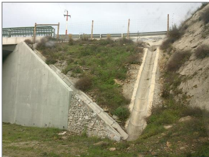
Figura 3.15 - Ponto de descarga das águas de escorrência da plataforma ao km 5+325.
