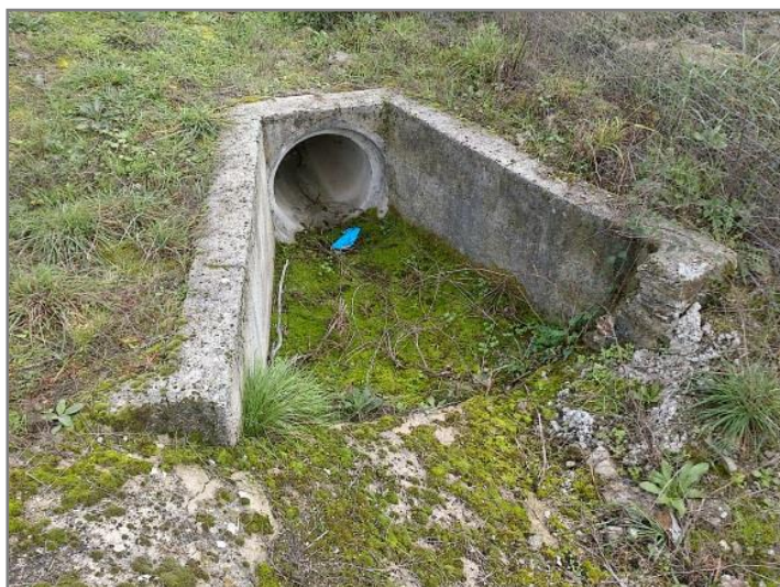
Figura 3.14 - Ponto de descarga das águas de escorrência da plataforma ao km 5+300.
