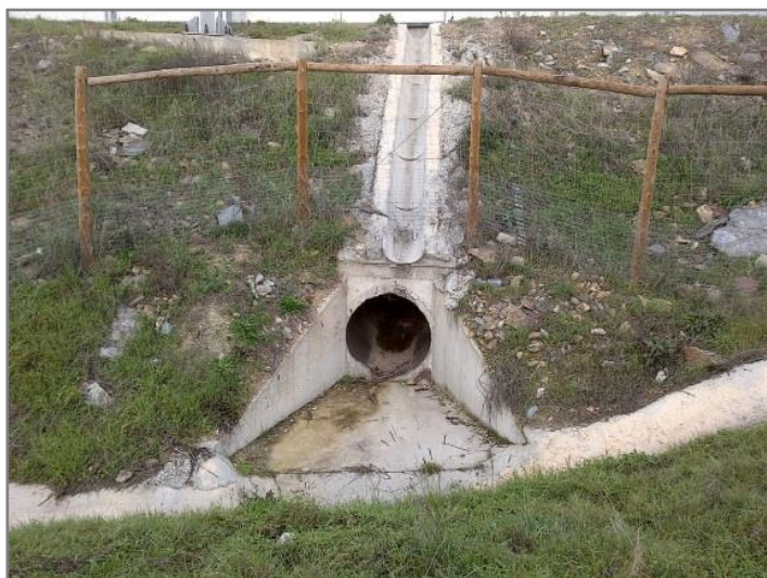
Figura 3.16 - Ponto de descarga das águas de escorrência da plataforma ao km 5+705 (PH 5-3).
