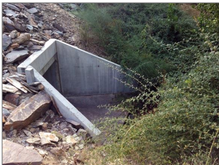
Figura 3.12 – Ribeira da Caravela, a jusante.
