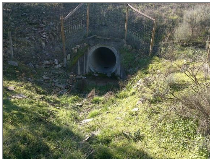
Figura 3.1 – Afluente do Vale das Brespas, a montante da via, ao km 1+329.
