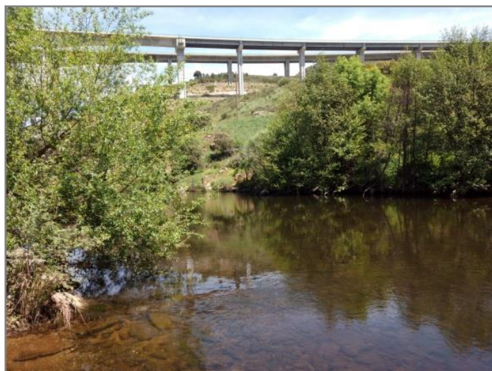
Figura 3.4 – Rio Sabor, a jusante da via, localizado ao km 2+695.
