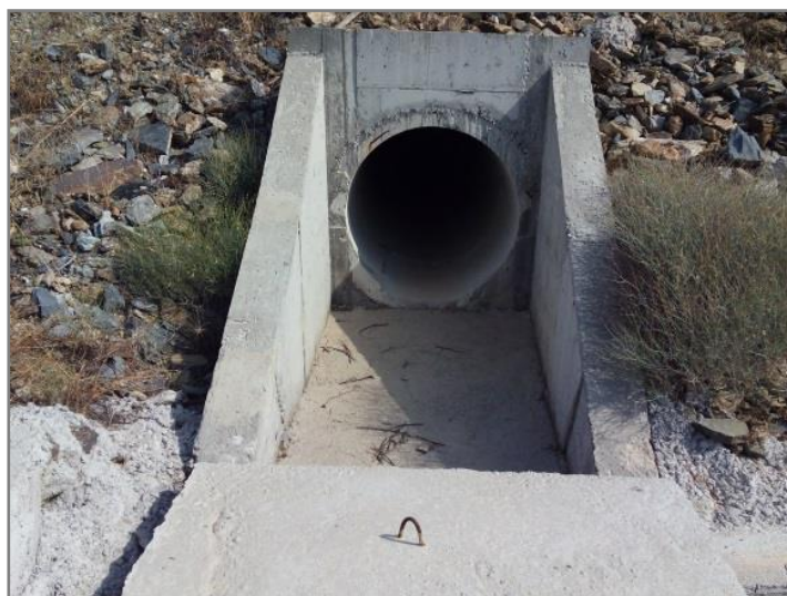
Figura 3.2 - Afluente do Vale das Brespas, a jusante da via, ao km 1+329.
