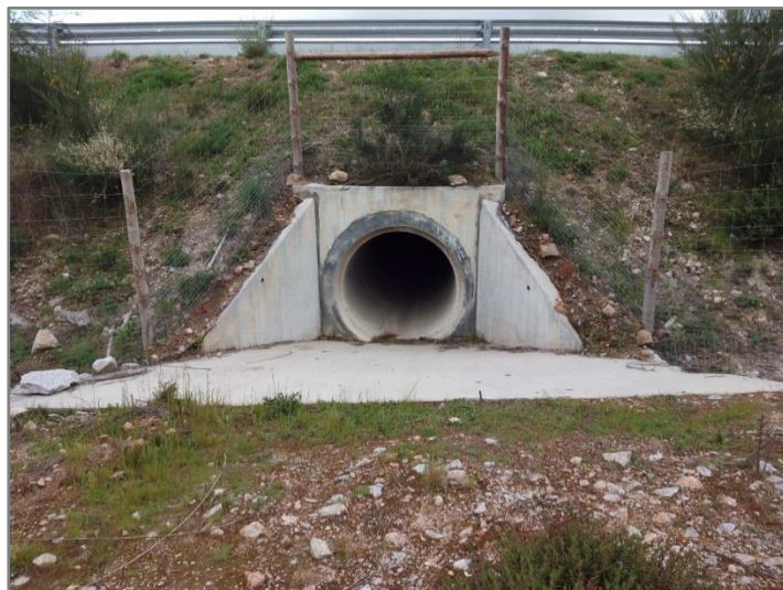
Figura 3.5 – Afluente do rio Ferreiros, a montante da PH 9.1, localizado ao km 9+447.
