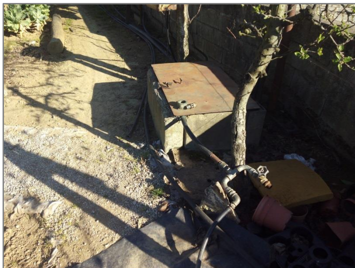
Figura 3.11 – Furo localizado ao km 0+050 do lado esquerdo da via
