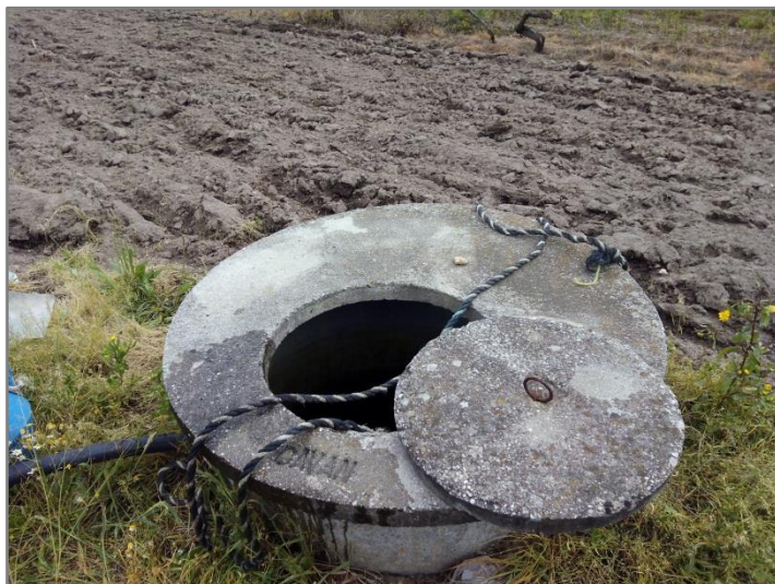
Figura 3.13 – Poço localizado ao km7+525 do lado direito da via
