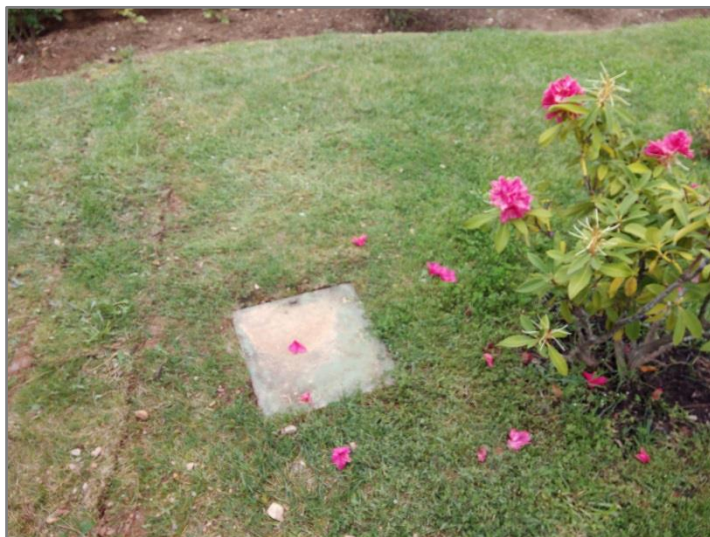
Figura 3.17 – Furo localizado ao km 3+675 do lado esquerdo da via
