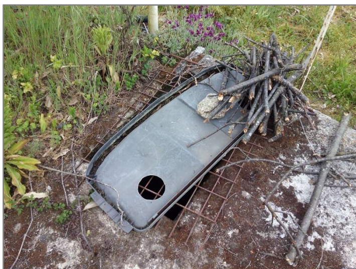
Figura 3.14 – Poço localizado ao km 7+675 do lado direito da via
