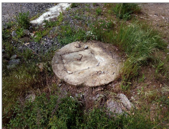
Figura 3.22 – Poço localizado ao km 5+750, entre os pilares do viaduto de Constantim.
