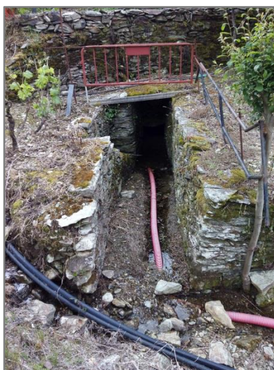
Figura 3.16 – Furo nº 30 localizado ao km 2+900, sob o tabuleiro do viaduto do rio Corgo.
