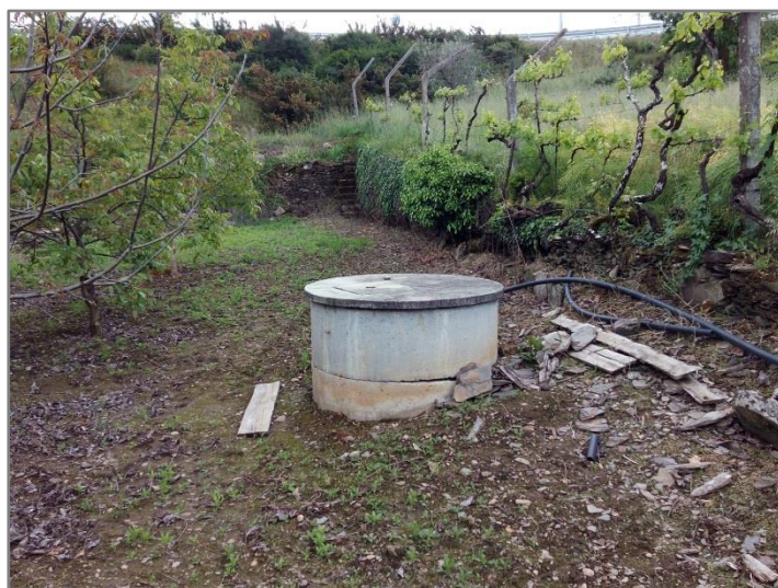
Figura 3.18 – Poço localizado ao km 0+550 da Variante à EN313 e 0+750 da Variante à Universidade
