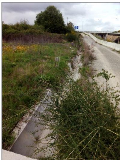
Figura 3.3 – Ribeira do Paul, a montante da PH 6.1, localizado ao km 6+640.
