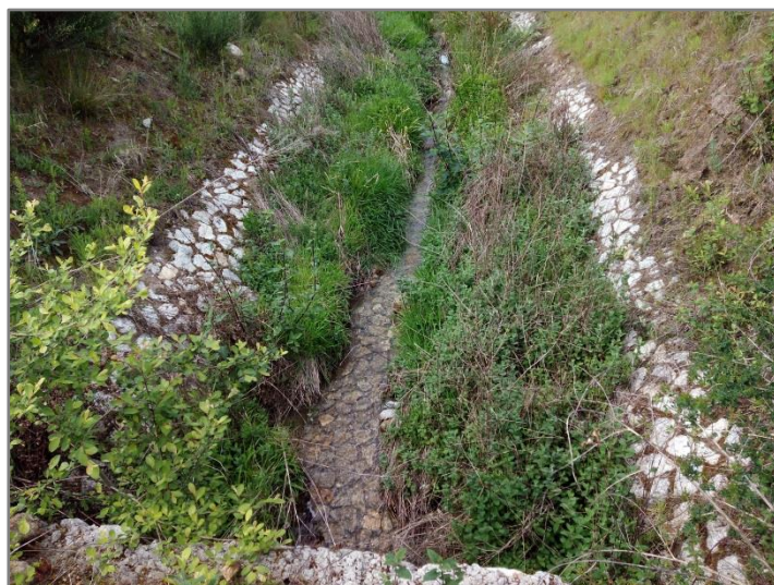
Figura 3.4 – Ribeira do Paul, a montante da PH 6.1, localizado ao km 6+640.
