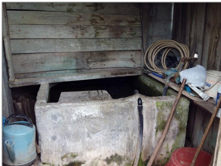
Figura 3.19 – Furo localizado ao km 0+000 da Rotunda V313-3
