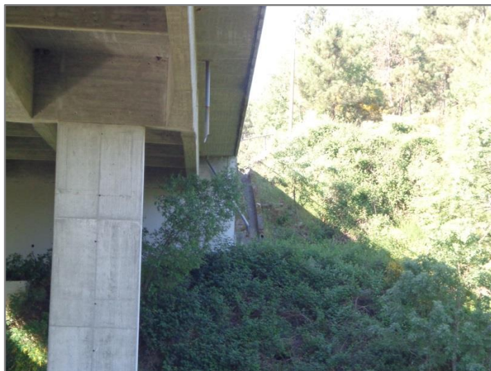
Figura 3.6 - Ponto de descarga das águas de escorrência da plataforma, localizado ao km 7+575, do lado esquerdo da via.
