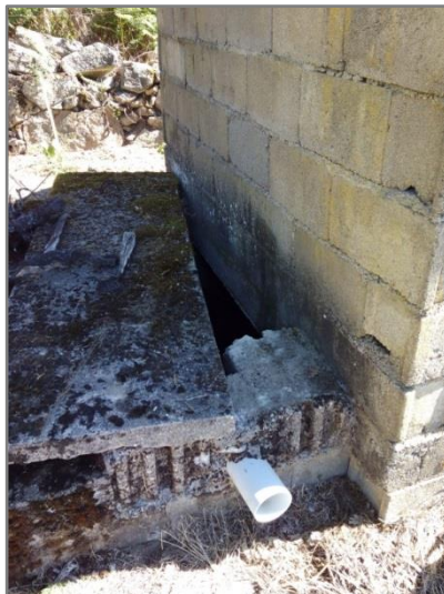
Figura 3.12 – Poço localizado ao km 6+520 do lado esquerdo da via
