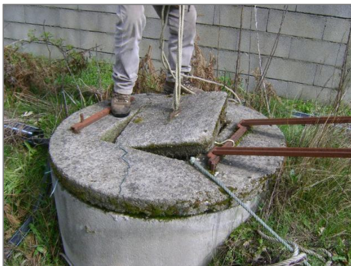
Figura 3.9 – Poço localizado no Nó de Lames.
