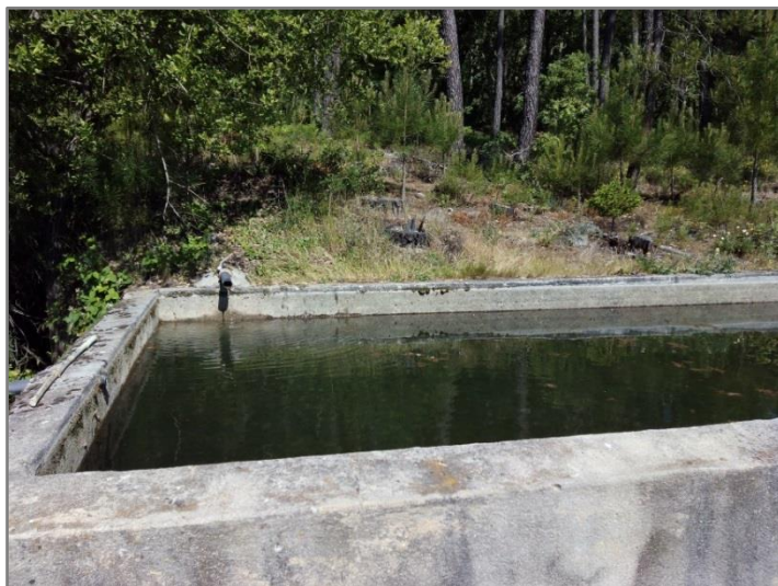
Figura 3.10 – Nascente localizada ao km 6+300, do lado esquerdo da via.
