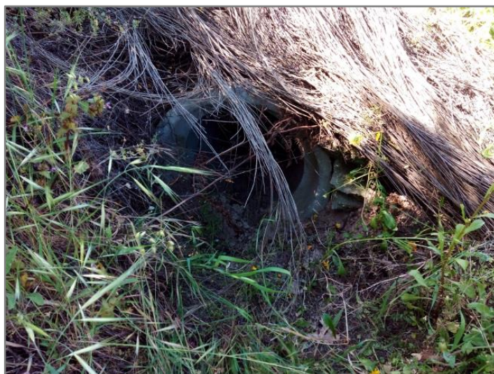
Figura 3.1 – Afluente da Ribeira de Justes, a montante da PH 6-1, localizado ao km ao km 6+500.
