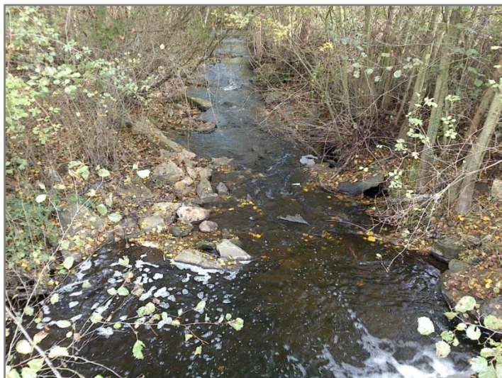
Figura 3.6 – Ribeira da Aila, a jusante da via, localizado ao km 6+886.
