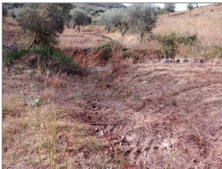
Figura 3.4 – Afluente da Ribeira de Carvalhais, a jusante da via, localizado ao km 3+375.
