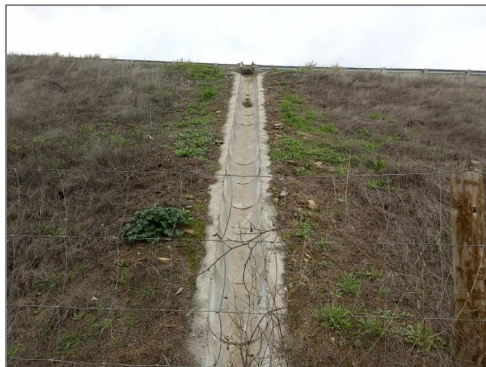
Figura 3.9 – Ponto de descarga das águas de escorrência da plataforma, localizado junto à linha de água restabelecida pela PH 0-1, ao km 0+225.
