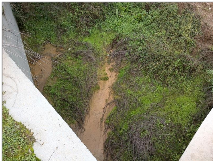
Figura 3.1 – Ribeira da Coitada, a montante da via, localizado ao km 0+225.
