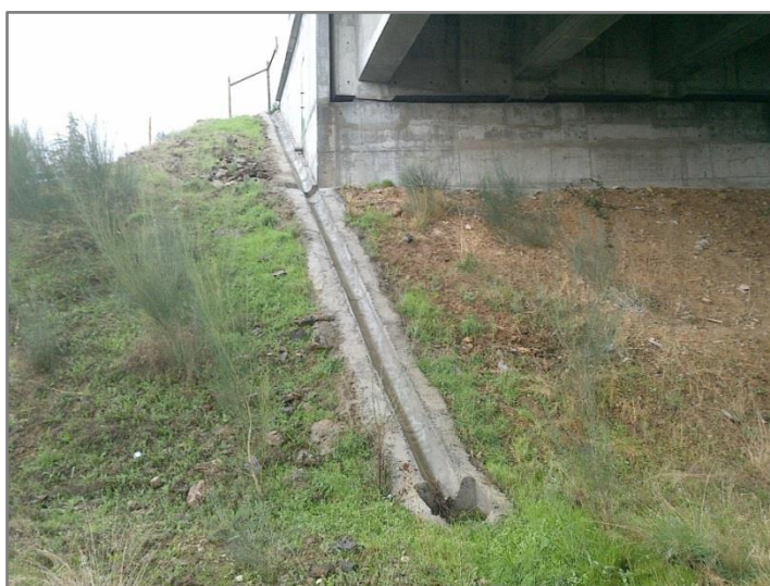
Figura 3.12 – Ponto de descarga das águas de escorrência da plataforma, localizado junto ao encontro direito do Viaduto sobre EN 15, ao km 10+985.
