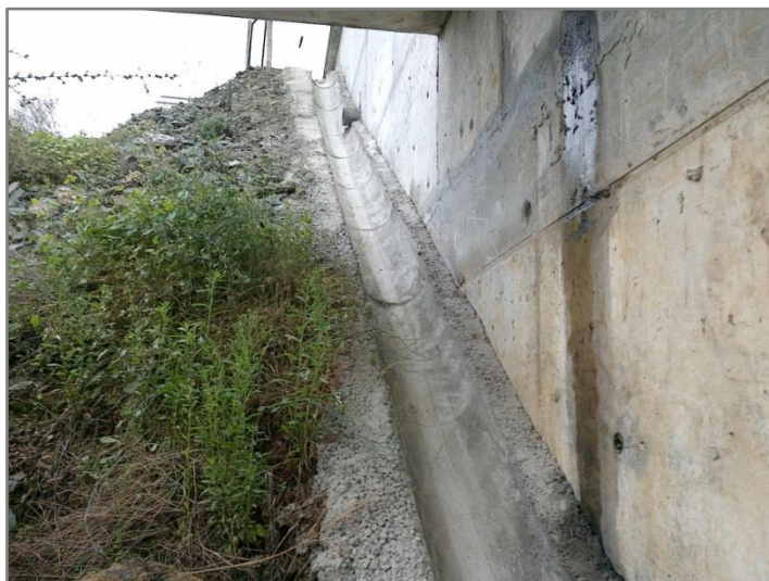
Figura 3.11 – Ponto de descarga das águas de escorrência da plataforma, localizado junto ao encontro esquerdo do viaduto sobre a Ribeira da Açoreira, ao km 3+900.
