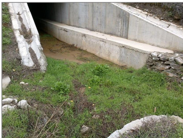
Figura 3.2 – Ribeira da Coitada, a jusante da via, localizado ao km 0+225.
