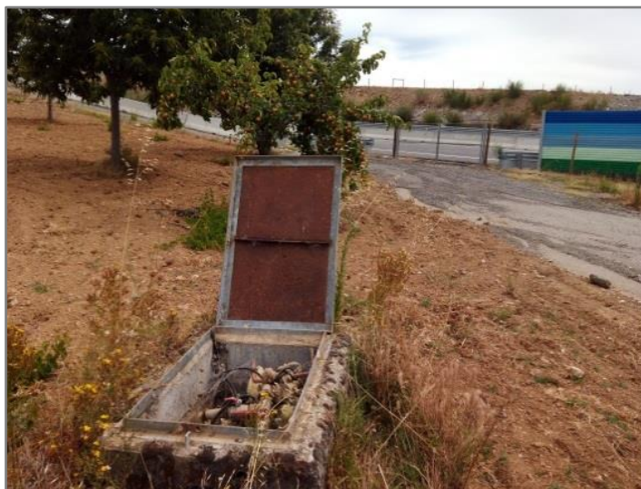
Figura 3.13 – P1, Furo Artesiano nº 6, ao km 0+275, do lado esquerdo da via.
