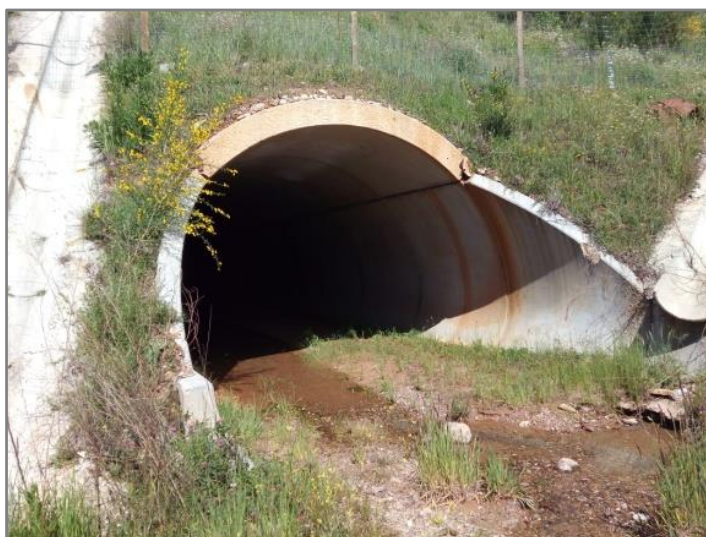
Figura 3.4 – Ribeira da Portela, a jusante da via, localizado ao km 9+090.
