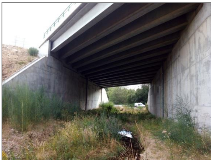
Figura 3.1 – Ribeira de Vale de Moinhos, a montante da via, ao km 2+128.
