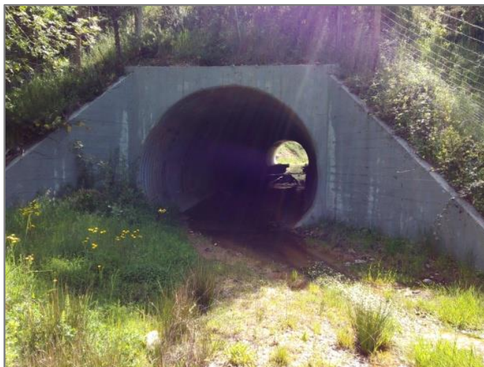
Figura 3.3 – Ribeira da Portela, a montante da via, localizado ao km 9+090.
