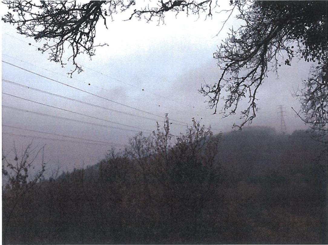
Fotografia 3 – Vão entre P65 e o P66 onde se visualizou ao fundo, faixa de servidão
