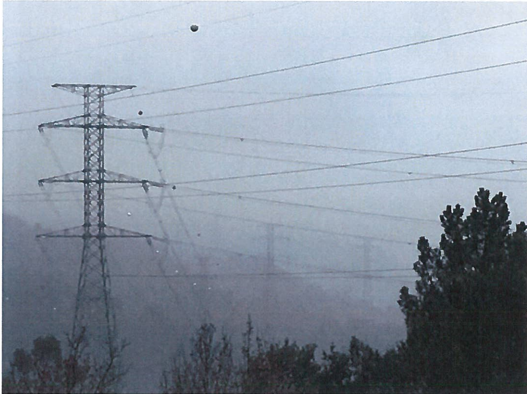
Fotografia 1 – Vão entre o P76 e o P77 onde se visualizou BFD
