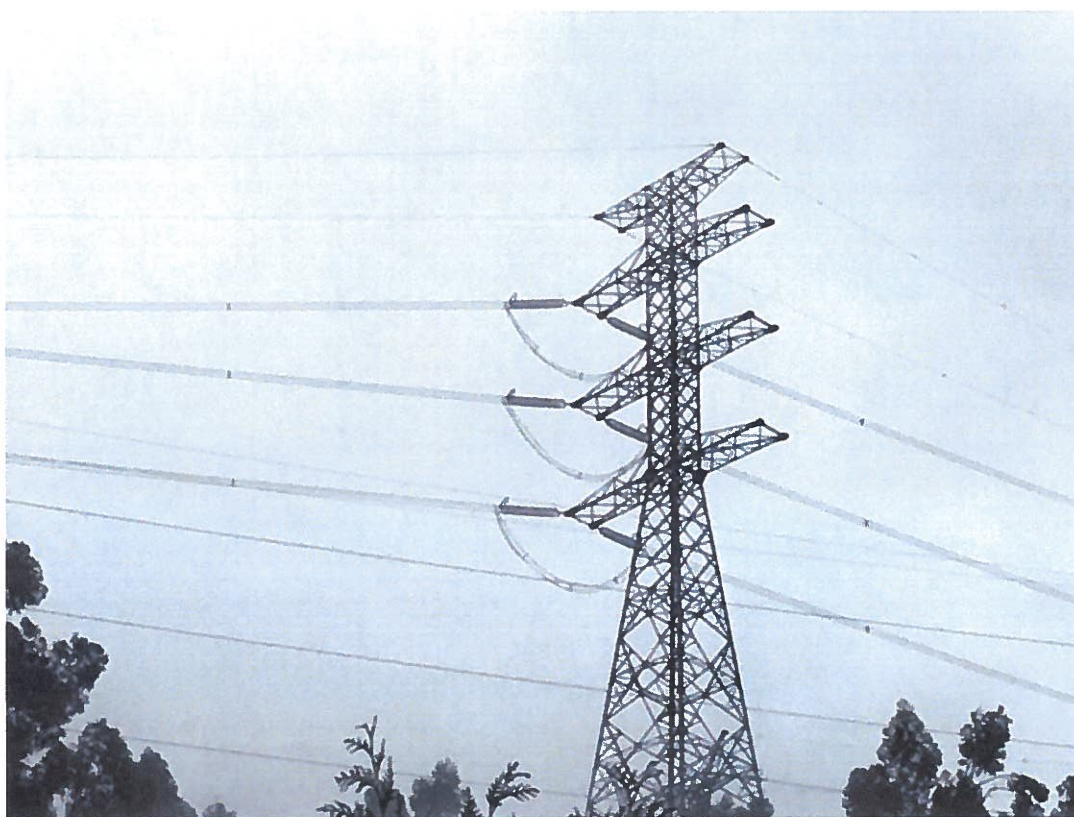
Fotografia 9 - Vista para P51 onde se visualizou BFD, no vão P51-P52
