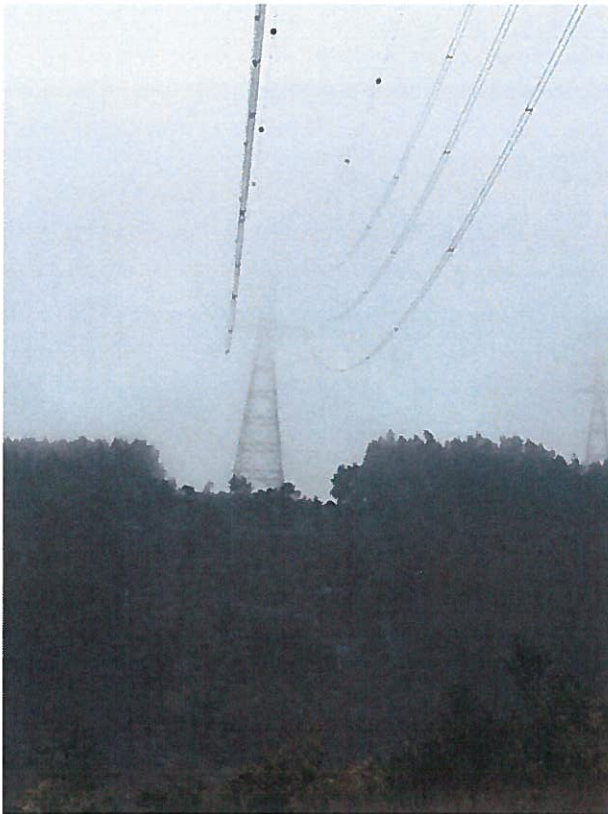
Fotografia 5 e Fotografia 6 - Vão entre o P61 e o P62 onde se visualizou BFD e balizagem aérea.
