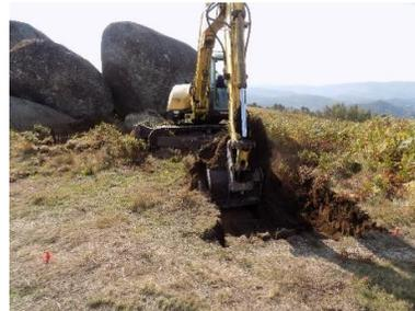
Figura 80 - Perspetiva geral dos trabalhos de decapagem. Cabouco E1 (Apoio 30/28).
