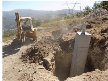
Figura 5 - Perspetiva geral dos trabalhos de decapagem do anel de terras (Apoio 4, LFRCAN).
