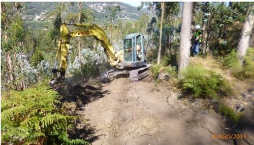
Figura 128 - Perspetiva geral da desmatamento e decapagem do acesso (Apoio 48, LFRCAN).
