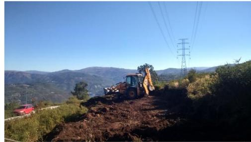
Figura 35 - Perspetiva geral da execução da plataforma de desenrolamento - Plataforma 1 (Apoio 14/12).
