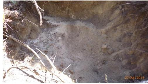
Figura 82 - Perspetiva geral dos trabalhos de decapagem. Cabouco D1 (Apoio 31/29).
