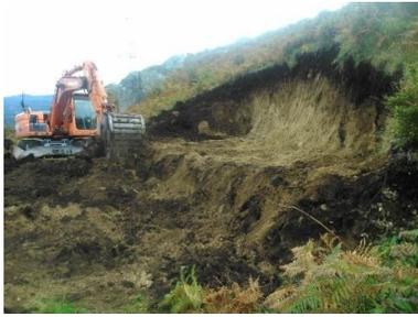
Figura 51 - Perspetiva geral da execução da plataforma para espimento do Apoio – Plataforma 1 (Apoio 19/17).
