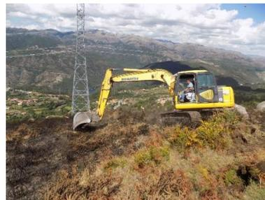
Figura 61 - Perspetiva geral dos trabalhos de decapagem. Cabouco D2 (Apoio 22/20).
