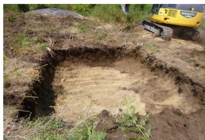
Figura 118 - Perspetiva geral dos trabalhos de decapagem. Cabouco D1 (Apoio 46/44).
