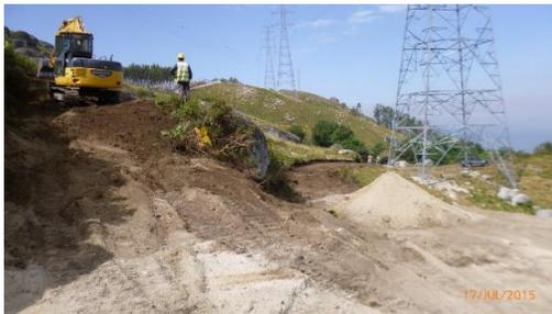
**Figura 84 - Perspetiva geral dos trabalhos de desmatamento do acesso (Apoio 32/30).**
