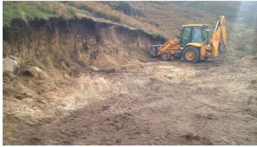
Figura 48 - Perspetiva geral da execução da plataforma de desenrolamento (Apoio 18/16).
