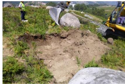
Figura 50 - Perspetiva geral dos trabalhos de decapagem. Cabouco E1 (Apoio 19/17).
