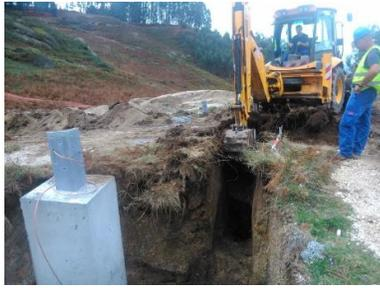
Figura 109 - Perspetiva geral da decapagem do anel de terras (Apoio 42/40).
