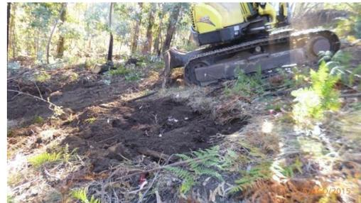
Figura 129 - Perspetiva dos trabalhos de decapagem. Cabouco E1 (Apoio 48, LFRCAN).
