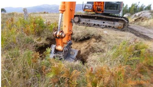
**Figura 107 - Perspetiva geral dos trabalhos de decapagem. Cabouco D1 (Apoio 42/40).**
