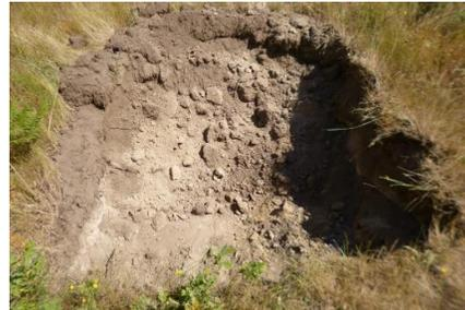
Figura 14 - Perspetiva geral dos trabalhos de decapagem. Cabouco D2 (Apoio 7, LFRCAN).
