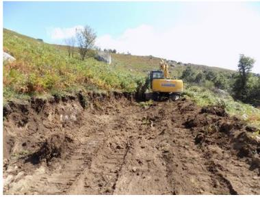
**Figura 74 - Perspetiva geral da desmatção e decapagem do acesso (Apoio 28/26).**
