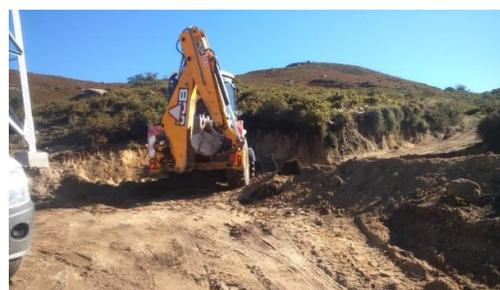
Figura 56 - Perspetiva geral da execução da plataforma de desenrolamento- Plataforma 2 (Apoio 20/18).
