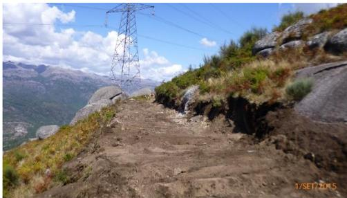
Figura 64 - Perspetiva geral após trabalhos de desmatação e decapagem do acesso (Apoio 24/22).
