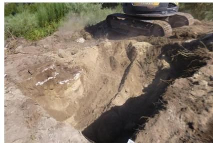
Figura 135 - Perspetiva geral dos trabalhos de decapagem. Cabouco E2 (Apoio 49).
