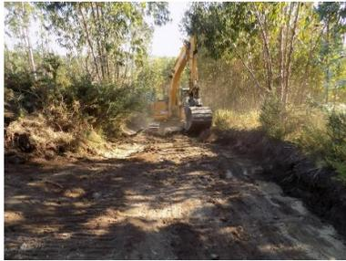
Figura 223 - Perspetiva geral dos trabalhos de desmatação e decapagem do acesso (Apoio 77).
