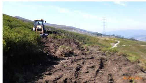
**Figura 40 - Perspetiva geral dos trabalhos de desmatamento e decapagem do acesso, para a plataforma de desenrolamento (Apoio 15/13).**
