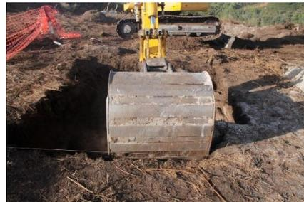
Figura 145 - Perspetiva geral dos trabalhos de decapagem. Cabouco E1 (Apoio 51).
