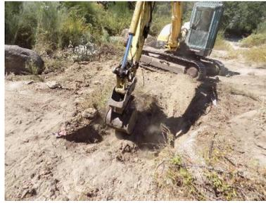
Figura 121 - Perspetiva geral dos trabalhos de decapagem. Cabouco E1 (Apoio 46, LFRCAN).
