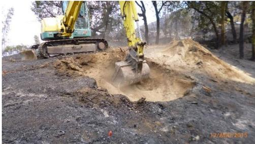
Figura 167 - Perspectiva geral dos trabalhos de decapagem. Cabouco E1 (Apoio 59).
