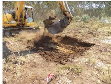
Figura 229 - Perspetiva geral dos trabalhos de decapagem. Cabouco E1 (Apoio 79).
