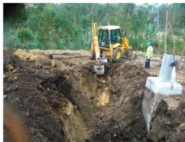
Figura 234 - Perspetiva geral dos trabalhos de decapagem do anel de terras (Apoio 80).
