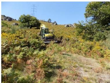
**Figura 68 - Perspetiva geral após trabalhos de desmatção e decapagem do acesso (Apoio 26/24).**
