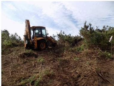
Figura 214 - Perspetiva geral dos trabalhos de desmatação e decapagem do acesso (Apoio 74).
