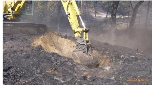
Figura 168 - Perspectiva geral dos trabalhos de decapagem. Cabouco E2 (Apoio 59).
