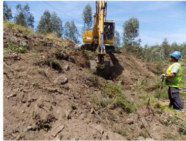
Figura 224 - Perspetiva geral dos trabalhos de decapagem. Cabouco D2 (Apoio 77).
