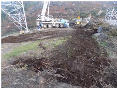
**Figura 139 - Perspetiva geral da decapagem da plataforma de desenrolamento - Plataforma 2 (Apoio 50).**
