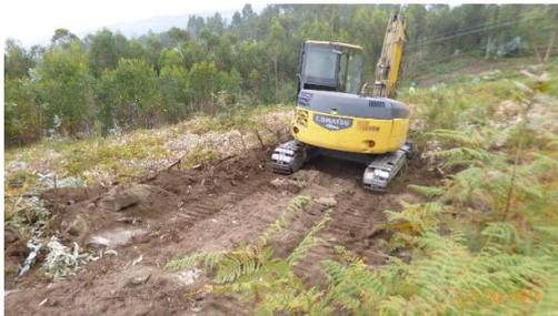
**Figura 211 - Perspetiva geral dos trabalhos de desmatação e decapagem do acesso (Apoio 73).**
