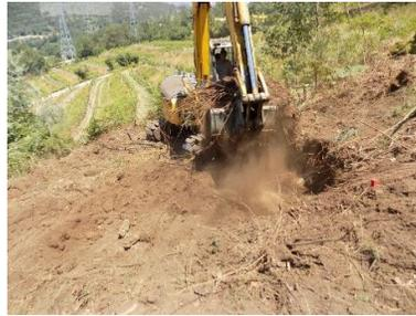
Figura 197 - Perspetiva geral dos trabalhos de decapagem. Cabouco E2 (Apoio 69).
