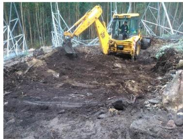
Figura 125 - Perspetiva geral da execução da plataforma de espiamento do Apoio (Apoio 47/45).
