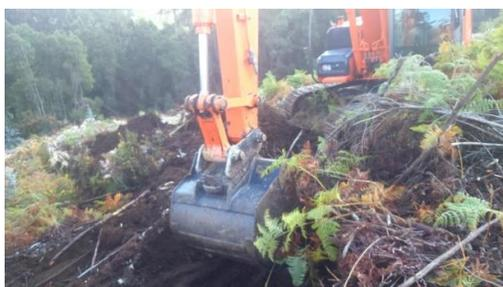
Figura 103 - Perspetiva geral dos trabalhos de desmatção e decapagem do acesso (Apoio 41 LVMPD1).
