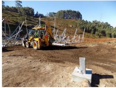
Figura 110 - Perspetiva geral da execução da plataforma (Apoio 42/40).
