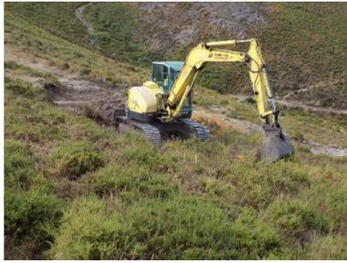
Figura 44 - Perspetiva geral dos trabalhos de desmatção e decapagem do acesso (Apoio 17/15).
