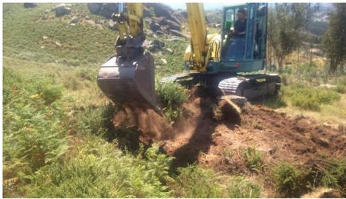
Figura 162 - Perspetiva geral dos trabalhos de decapagem. Cabouco D1 (Apoio 58).
