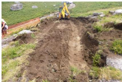
**Figura 86 - Perspetiva geral dos trabalhos de desmatamento e decapagem do acesso (Apoio 33/31).**
