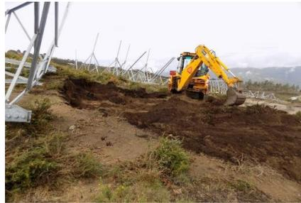
**Figura 158 - Perspetiva geral da execução da plataforma (Apoio 56).**
