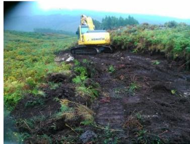
Figura 94 - Perspetiva geral dos trabalhos de desmatção e decapagem do acesso (Apoio 36/34).
