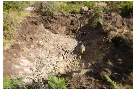
Figura 47 - Perspetiva geral dos trabalhos de decapagem. Cabouco E1 (Apoio 18/16).
