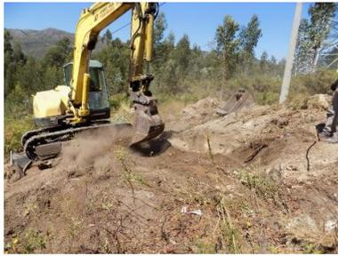
Figura 120 - Perspetiva geral dos trabalhos de decapagem. Cabouco D1 (Apoio 46, LFRCAN).
