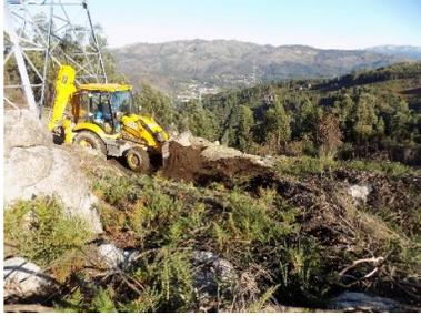
Figura 143 - Perspetiva geral da execução da plataforma para espiamento- Plataforma 2 (Apoio 50).
