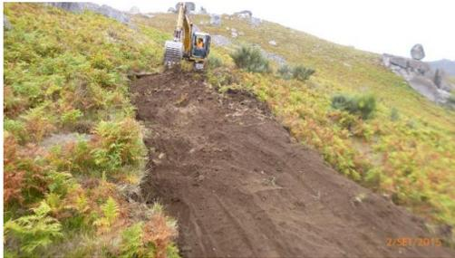
Figura 62 - Perspetiva geral dos trabalhos de desmatação e decapagem do acesso (Apoio 23/21).
