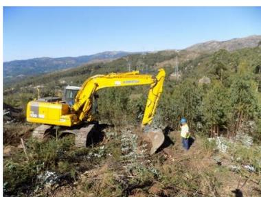
**Figura 180 - Perspetiva geral dos trabalhos de decapagem. Cabouco D1 (Apoio 63).**
