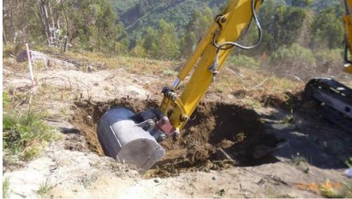
**Figura 136 - Perspetiva geral dos trabalhos de decapagem. Cabouco E1 (Apoio 50).**
