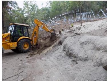
Figura 195 - Perspetiva geral da execução da plataforma (Apoio 68).
