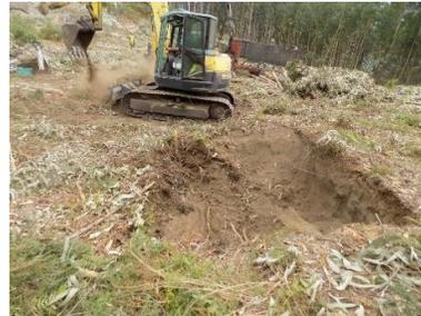
Figura 124 - Perspetiva geral dos trabalhos de decapagem. Cabouco D1 (Apoio 47/45).
