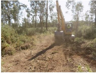
Figura 226 - Perspetiva geral dos trabalhos de desmatção e decapagem do acesso (Apoio 78).
