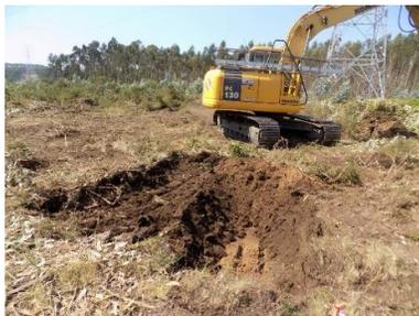
Figura 228 - Perspetiva geral dos trabalhos de decapagem. Cabouco D2 (Apoio 79).
