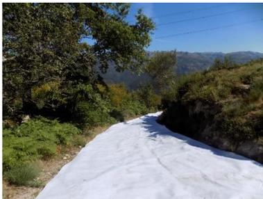
Figura 53 - Perspetiva geral da calçada coberta com geotêxtil, no acesso ao Apoio (Apoio 20/18).
