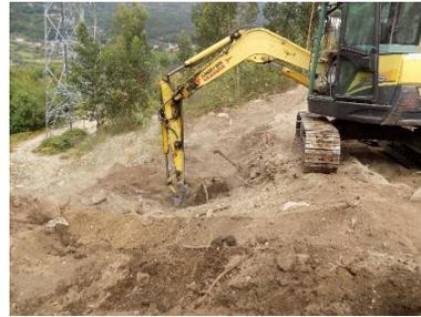
Figura 127 - Perspetiva geral dos trabalhos de decapagem. Cabouco E2 (Apoio 47, LFRCAN).
