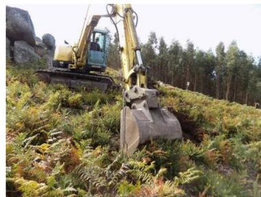
**Figura 78 - Perspetiva geral dos trabalhos de decapagem. Cabouco E2 (Apoio 29/27).**
