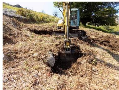
**Figura 69 - Perspetiva geral dos trabalhos de decapagem. Cabouco E2 (Apoio 26/24).**
