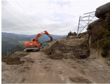
Figura 59 - Perspetiva geral da execução da plataforma (Apoio 21/19).
