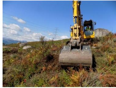
**Figura 75 - Perspetiva geral dos trabalhos de decapagem. Cabouco E2 (Apoio 28/26).**
