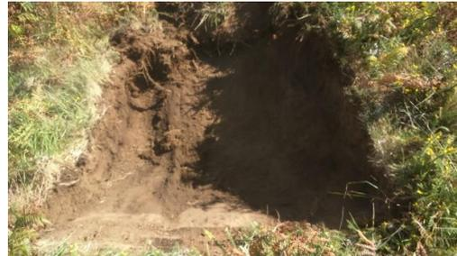
**Figura 67 - Perspetiva geral dos trabalhos de decapagem. Cabouco D1 (Apoio 25/23).**
