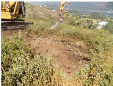
**Figura 38 - Perspetiva geral dos trabalhos de decapagem. Cabouco E2 (Apoio 15/13).**
