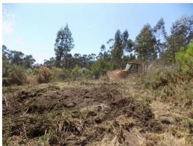
Figura 231 - Perspetiva após a desmatção e decapagem do acesso (Apoio 80).
