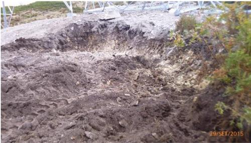
Figura 34 - Perspetiva geral da execução da plataforma (Apoio 14/12).
