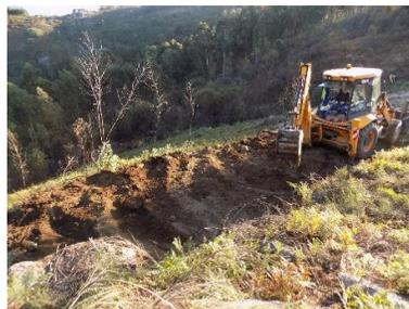
**Figura 142 - Perspetiva geral da execução da plataforma para espimento- Plataforma 1 (Apoio 50).**
