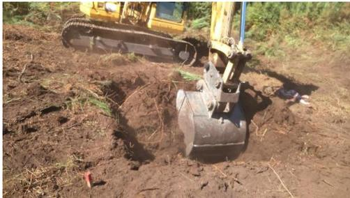
Figura 205 - Perspetiva geral dos trabalhos de decapagem. Cabouco E2 (Apoio 72).
