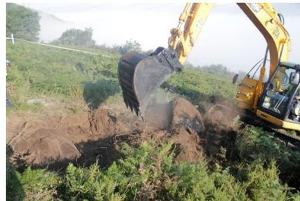
Figura 54 - Perspetiva geral dos trabalhos de decapagem. Cabouco D1 (Apoio 20/18).
