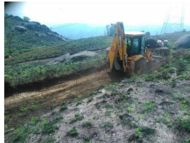
Figura 165 - Perspetiva geral dos trabalhos de decapagem e desmatção do acesso, para a plataforma de espionamento (Apoio 58).
