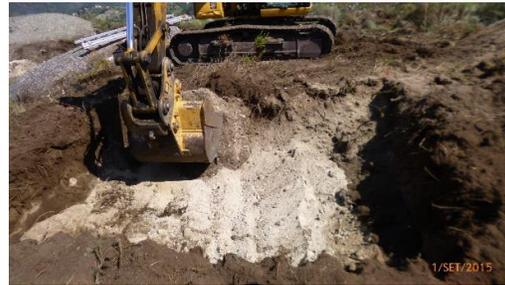
Figura 63 - Perspetiva geral dos trabalhos de decapagem. Cabouco E1 (Apoio 23/21).
