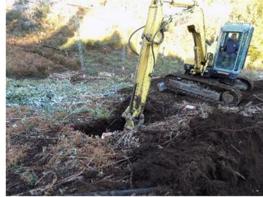
**Figura 106 - Perspetiva geral dos trabalhos de decapagem. Cabouco E2 Apoio 41/39).**
