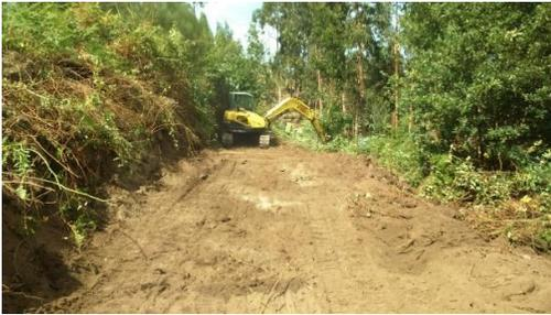
Figura 126 - Perspetiva geral dos trabalhos de desmatamento e decapagem do acesso (Apoio 47, LFRCAN).
