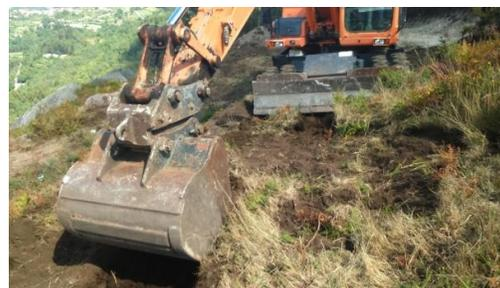
Figura 58 - Perspetiva geral dos trabalhos de decapagem. Cabouco E1 (Apoio 21/19).
