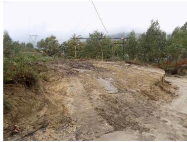
Figura 122 - Perspetiva geral da execução da plataforma de espionamento e desenrolamento (Apoio 46, LFRCAN).
