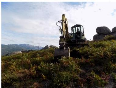
**Figura 77 - Perspetiva geral dos trabalhos de decapagem. Cabouco E1 (Apoio 29/27).**
