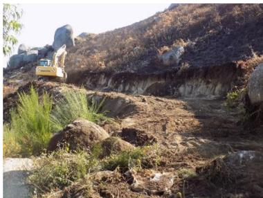
Figura 60 - Perspetiva geral dos trabalhos de desmatção e decapagem do acesso (Apoio 22/20).
