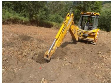
Figura 200 - Perspetiva geral dos trabalhos de decapagem. Cabouco D1 (Apoio 70).
