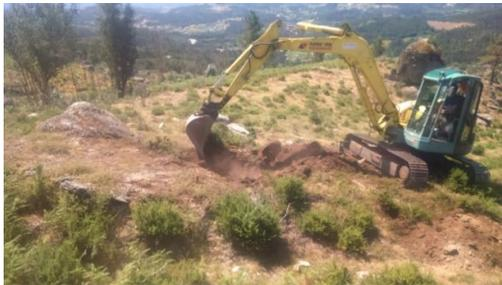
Figura 163 - Perspetiva geral dos trabalhos de decapagem. Cabouco D2 (Apoio 58).
