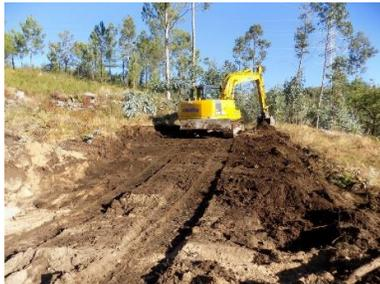
Figura 219 - Perspetiva geral dos trabalhos de desmatção e decapagem do acesso (Apoio 76).
