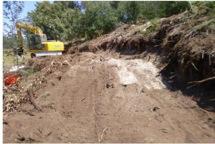
Figura 196 - Perspetiva geral dos trabalhos de desmatamento e decapagem do acesso (Apoio 69).
