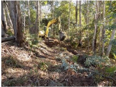
Figura 99 - Perspectiva geral dos trabalhos de desmatamento e decapagem do acesso (Apoio 39/37).
