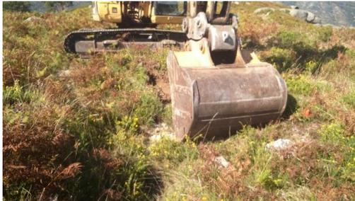
**Figura 66 - Perspetiva geral dos trabalhos de decapagem. Cabouco E2 (Apoio 25/23).**
