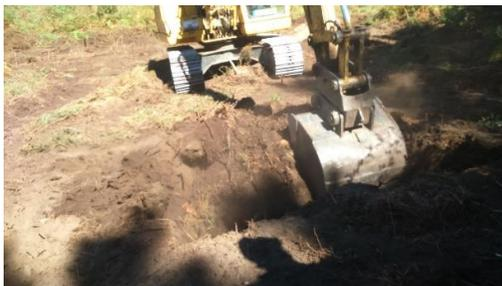
Figura 206 - Perspetiva geral dos trabalhos de decapagem. Cabouco D2 (Apoio 72).
