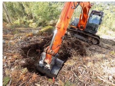
Figura 102 - Perspectiva dos trabalhos de decapagem . Cabouco E1 (Apoio 40/38).
