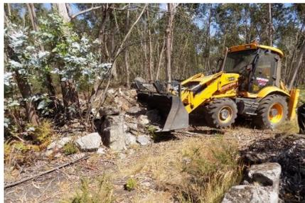
Figura 230 - Perspetiva do desmonte do muro de divisão de propriedade, junto ao acesso do Apoio 80.
