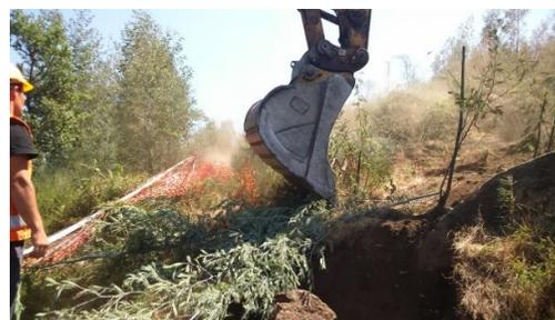
Figura 24 - Perspetiva geral dos trabalhos de decapagem. Cabouco E1 (Apoio 11/9).
