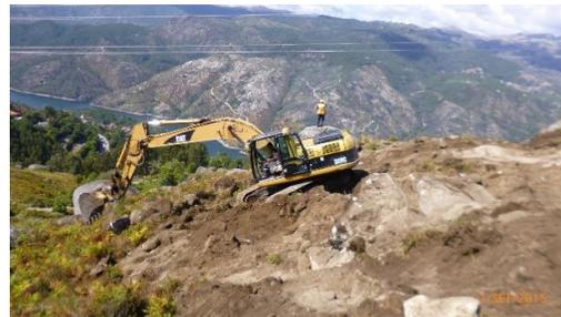
Figura 65 - Desaterro da área de implantação do Apoio (Apoio 24/22).
