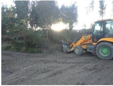
Figura 119 - Perspetiva geral do alargamento do acesso pré-existente (Apoio 46 LFRCAN).
