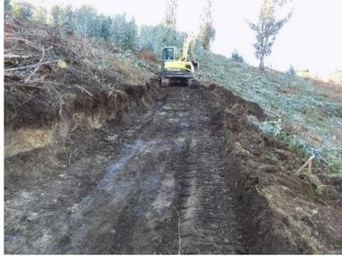
**Figura 105 - Perspetiva geral dos trabalhos de desmatação e decapagem do acesso (Apoio 41/39).**
