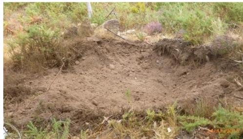
Figura 233 - Perspetiva geral dos trabalhos de decapagem. Cabouco E1 (Apoio 80).
