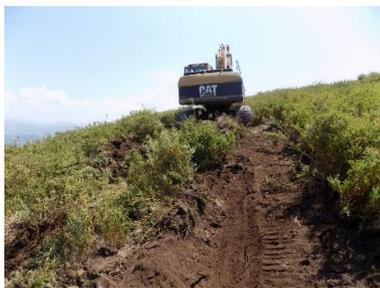
**Figura 37 - Perspetiva geral dos trabalhos de desmatamento e decapagem do acesso (Apoio 15/13).**
