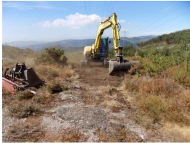
Figura 183 - Perspetiva geral dos trabalhos de desmatamento e decapagem do acesso (Apoio 64).
