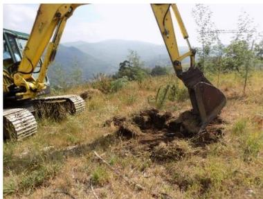
Figura 4 - Perspetiva geral dos trabalhos de decapagem. Cabouco E2 (Apoio 4, LFRCAN).
