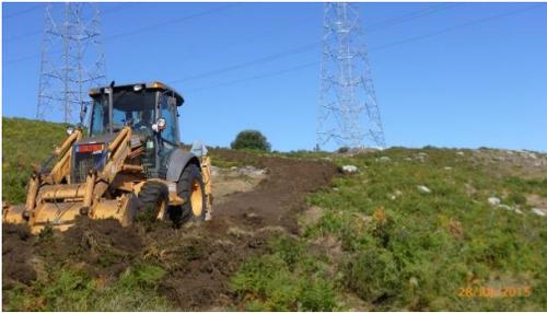
Figura 152 - Perspetiva geral dos trabalhos de decapagem e desmatção do acesso (Apoio 55).
