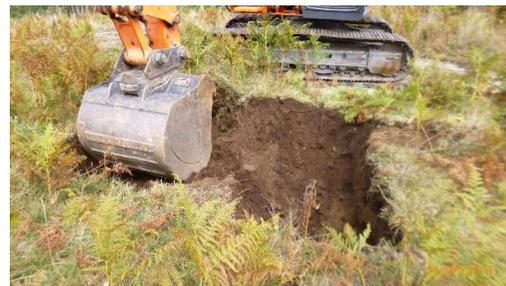
**Figura 108 - Perspetiva geral dos trabalhos de decapagem. Cabouco E1 (Apoio 42/40).**
