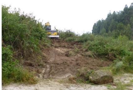
Figura 117 - Perspetiva geral dos trabalhos de desmatção e decapagem do acesso (Apoio 46/44).
