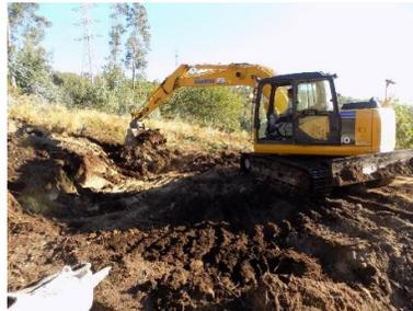
Figura 221 - Perspetiva geral da execução da plataforma-Plataforma 1 (Apoio 76).
