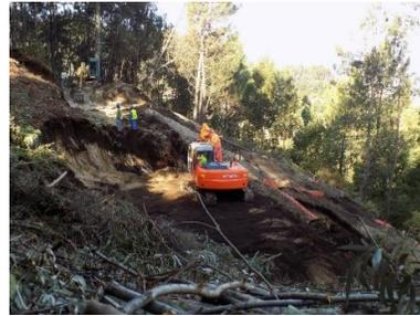
Figura 100 - Desaterro da área de implantação do Apoio (Apoio 39/37).
