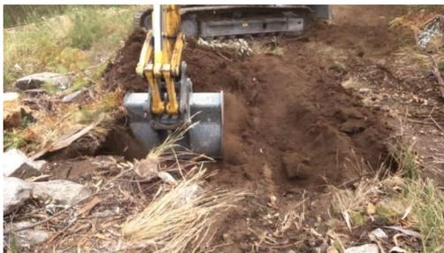
Figura 220 - Perspetiva geral dos trabalhos de decapagem. Cabouco E1 (Apoio 76).
