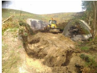
Figura 166 - Perspetiva geral da execução da plataforma de espionamento (Apoio 58).
