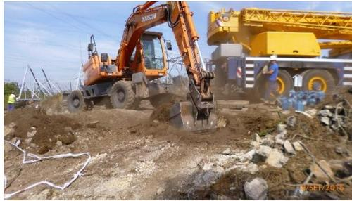
Figura 17 - Perspetiva geral da execução da plataforma (Apoio 8, LFRCAN)
