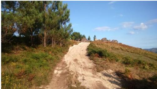
Figura 79 - Perspetiva geral do acesso, após aterro (Apoio 30/28).
