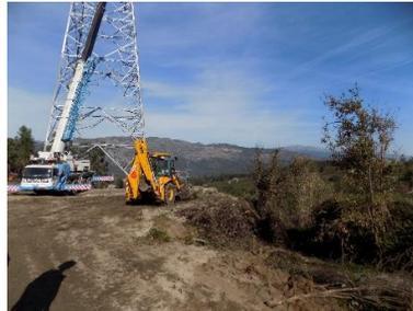
**Figura 140 - Perspetiva geral da decapagem da plataforma de desenrolamento - Plataforma 3 (Apoio 50).**
