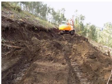
Figura 101 - Perspetiva geral dos trabalhos de desmatamento e decapagem do acesso (Apoio 40/38).
