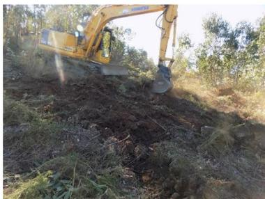
**Figura 179 - Perspetiva geral dos trabalhos de desmatação e decapagem da área de trabalho (Apoio 63).**
