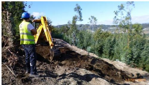
Figura 198 - Perspetiva geral da execução da plataforma (Apoio 69).
