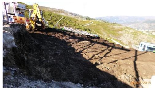
**Figura 39 - Perspetiva geral da execução da plataforma (Apoio 15/13).**
