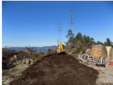
**Figura 141 - Perspetiva geral dos trabalhos de desmatção e decapagem do acesso à plataforma para espimento - Plataforma 1 (Apoio 50).**
