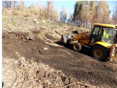
Figura 155 - Perspetiva geral da execução da plataforma de desenrolamento (Apoio 55).
