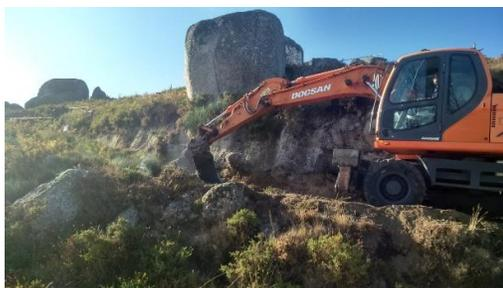
Figura 57 - Perspetiva geral dos trabalhos de desmatção e decapagem do acesso (Apoio 21/19).
