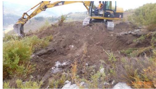
Figura 30 - Perspetiva geral dos trabalhos de decapagem. Cabouco E2 (Apoio 13/11).
