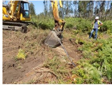
Figura 227 - Perspetiva geral dos trabalhos de decapagem. Cabouco E1 (Apoio 78).
