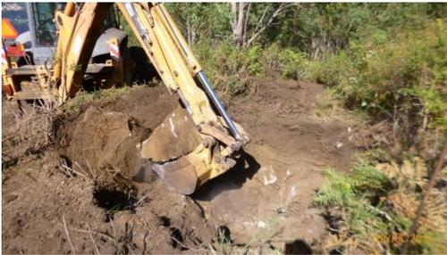
Figura 153 - Perspetiva geral dos trabalhos de decapagem. Cabouco D1 (Apoio 55).
