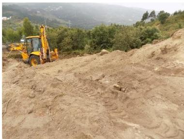
Figura 185 - Perspetiva geral dos trabalhos de desmatamento e decapagem do acesso (Apoio 65).
