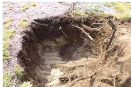
**Figura 87 - Perspetiva geral dos trabalhos de decapagem. Cabouco E2 (Apoio 33/31).**
