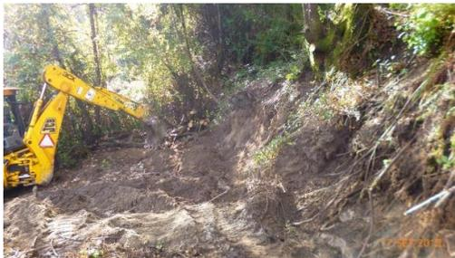
Figura 199 - Perspetiva geral dos trabalhos de desmatamento e decapagem do acesso (Apoio 70).
