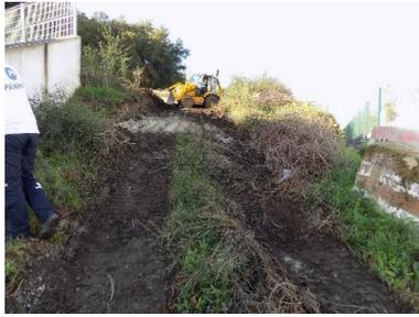
**Figura 209 - Perspetiva geral da desmatação e decapagem do acesso à plataforma de desenrolamento - Plataforma 2 (Apoio 72).**
