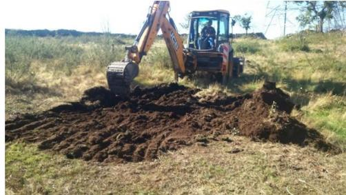
Figura 12 - Perspetiva geral da execução da plataforma de desenrolamento (Apoio 6, LVMPD2).
