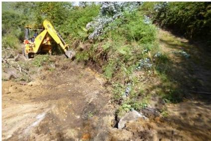
Figura 144 - Perspetiva geral dos trabalhos de decapagem e desmatação do acesso (Apoio 51).
