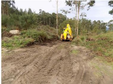
Figura 123 - Perspetiva geral dos trabalhos de desmatação e decapagem do acesso (Apoio 47/45).
