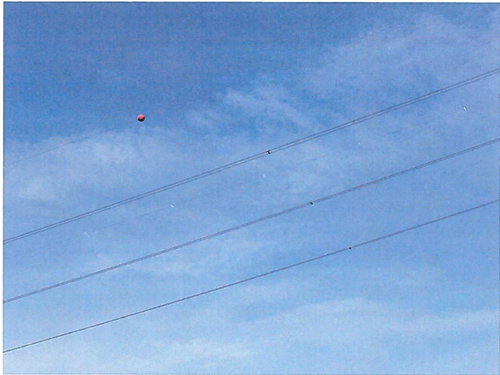
Fotografia 4 – Presença de BFD no vão P39-P40
