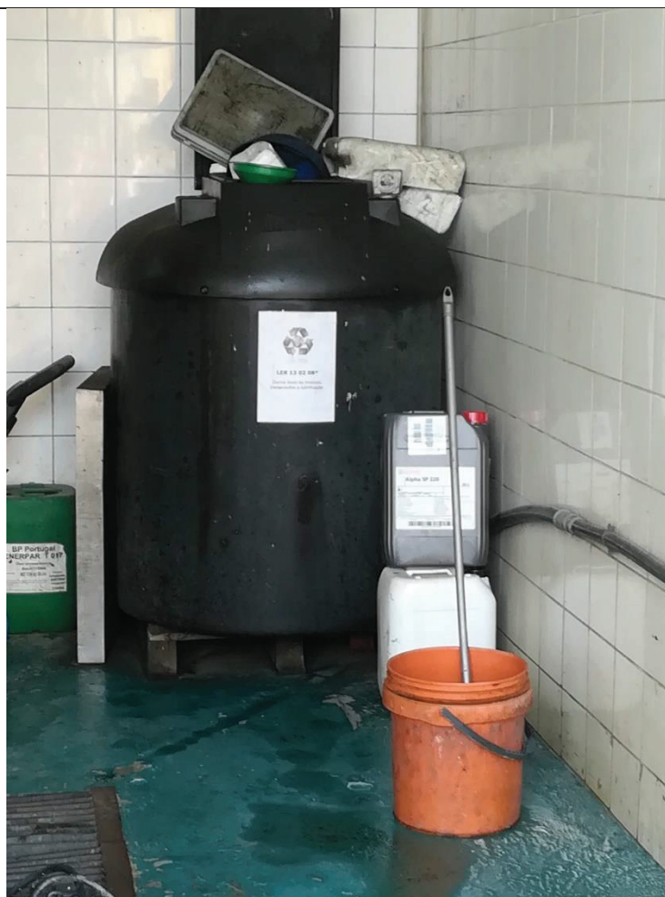
Armazenamento de óleos usados devidamente acondicionado e identificado
