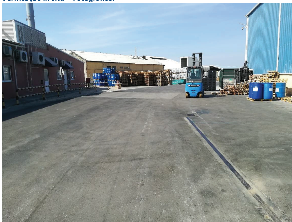
Aspeto do pavimento reparado em fevereiro de 2020 à data da auditoria (10.09.2020)
