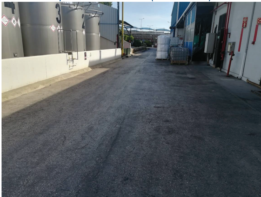
Depósitos com bacias de retenção
