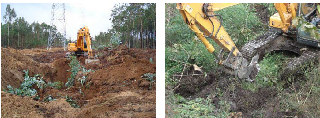
Figura 36 - Eliminação de cepos
