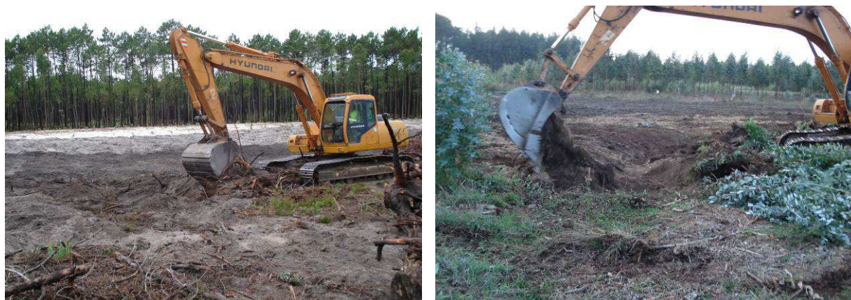
Figura 1 e 2 - Arranque e enterramento de toijas/cepos com escavadora giratória
