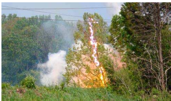
Figura 13 - Danos provocados pelo incumprimento das distâncias mínimas de segurança.
