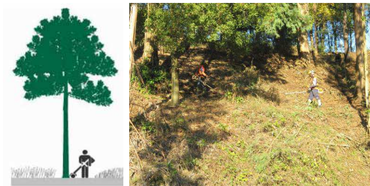
Figura 28 - Limpeza de matos moto-manual
