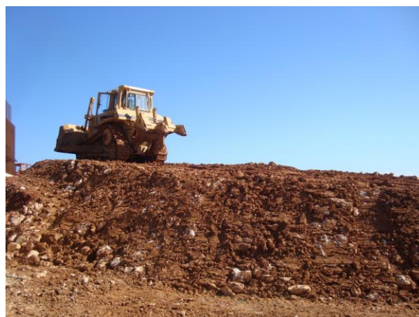
Foto 31- Aterro na zona do Reator Biológico
