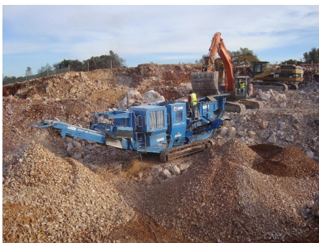
Foto 32- Britagem de pedra em obra
