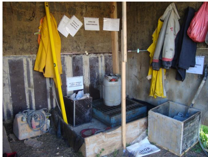
Foto 22 – Bacia de Retenção junto ao Edifício de Exploração
