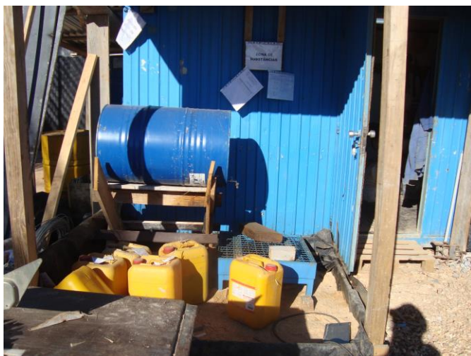
Foto 21 – Bacia de Retenção junto ao Reator Biológico
