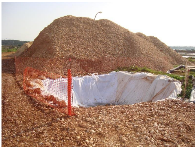
Foto 12 – Zona de lavagem de autobetoneira recente
