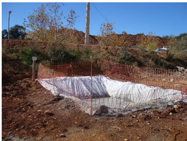
Foto 11 – Zona de lavagem de autobetoneiras que foi desativada
