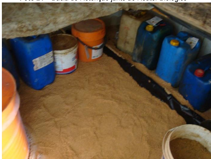
Foto 23 – Bacia de Retenção na ferramentaria
