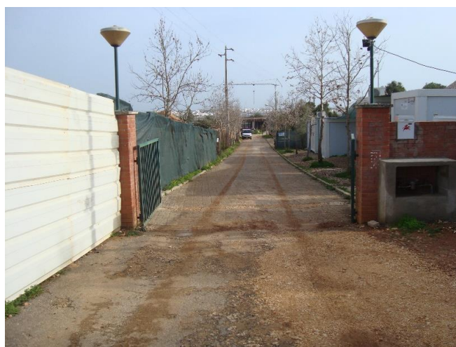
Foto 3 – Entrada de Acesso à ETAR
