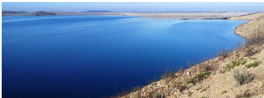
Fig.2 - Aspecto da instalação de resíduos (BE-BAC).
