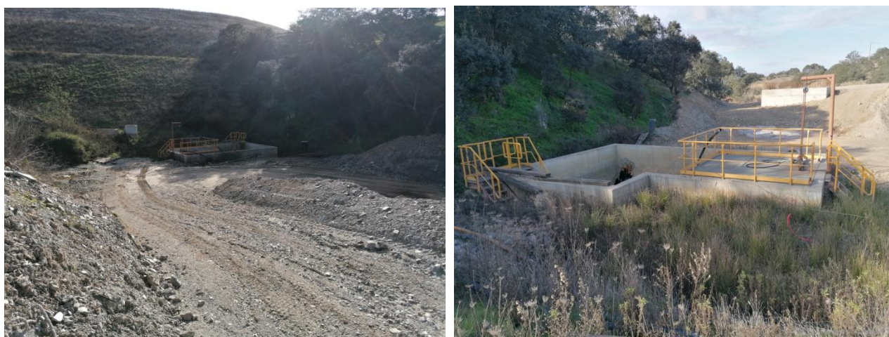
Fig. 9 - Aspecto geral do tanque de captação.
