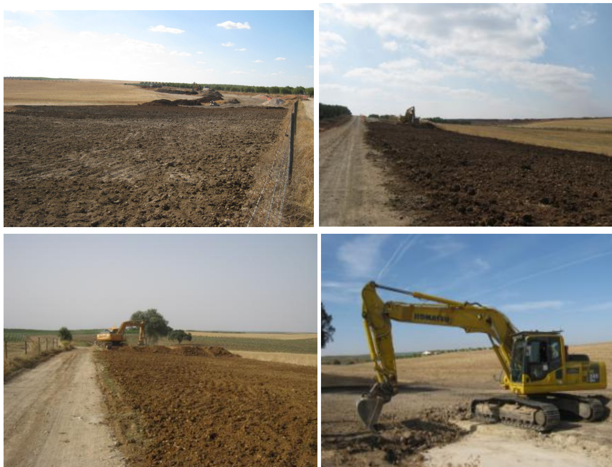
Figura 16 – Trabalhos de Aterro
