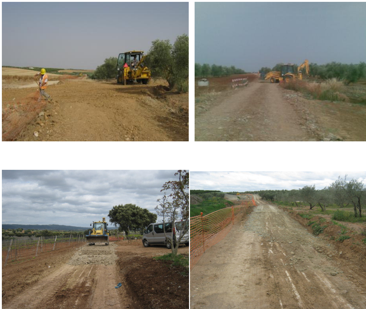
Figura 23 – Trabalhos de beneficiação de caminhos de acesso
