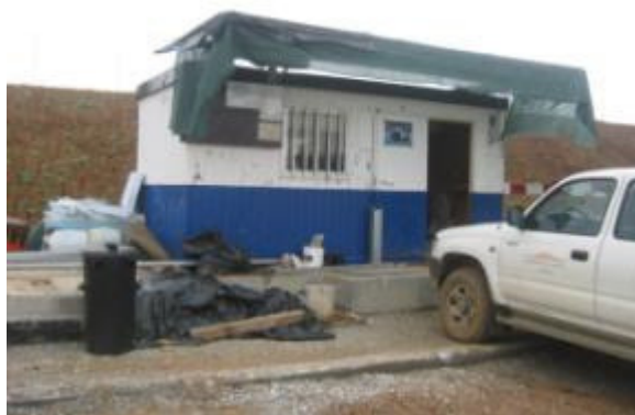
Figura 9 – Contentor escritório existente na Estação Elevatória
