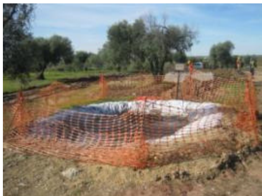
Figura 15 - Área de lavagem de caleiras
