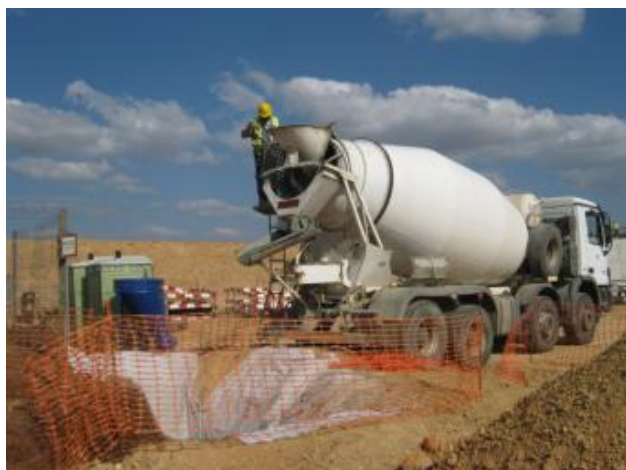
Figura 11 – Lavagem de caleiras
