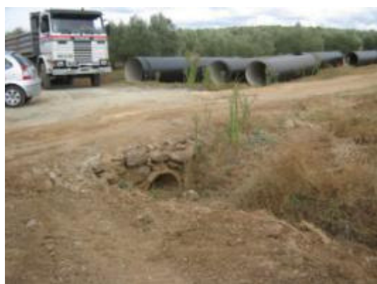
Figura 25 – Linha de água (sem designação) – Nó N0302, antes do atravessamento
