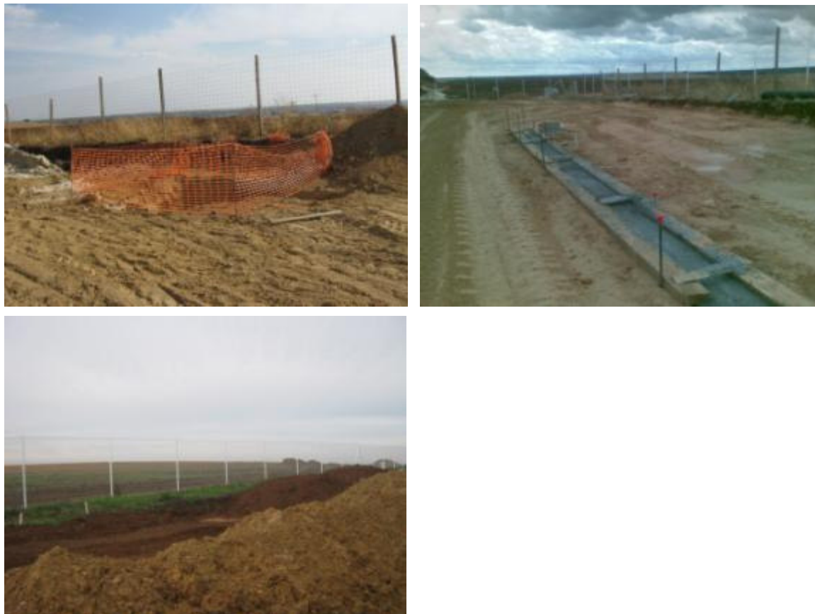
Figura 7 – Vedação provisória e definitiva da Estação Elevatória
