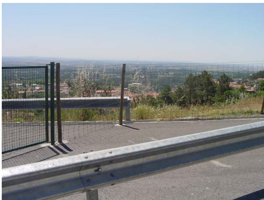
Fotografia 2 – Envoltente do local de amostragem Emboquilhamento Sul - Túnel 1
