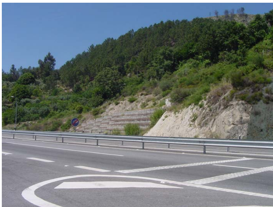
Fotografia 3 – Envolvente do local de amostragem Emboquilhamento Sul - Túnel 1
