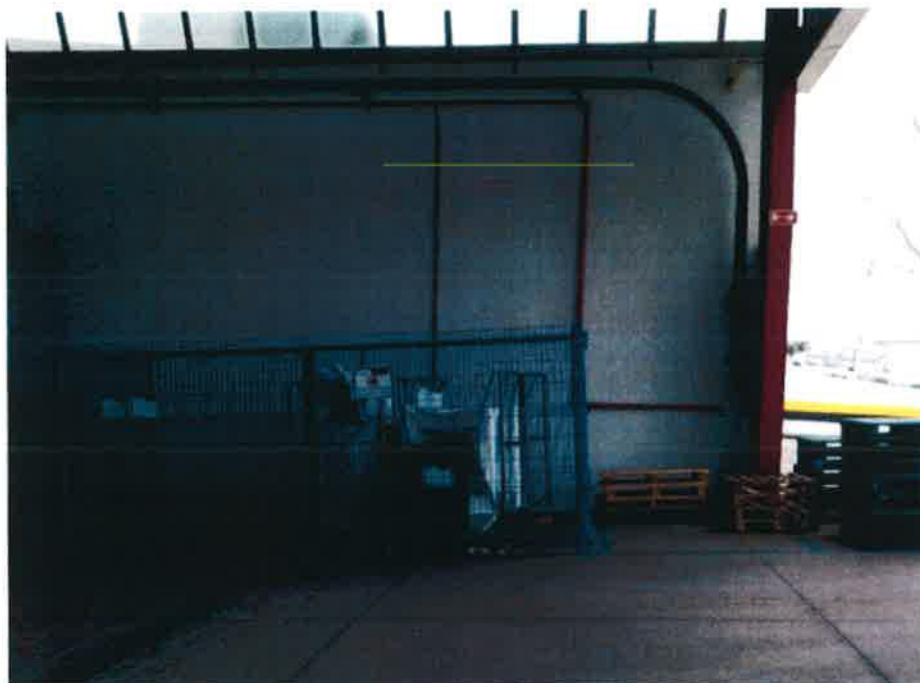
Figura 11 – Nova zona de armazenamento de resíduos sólidos
