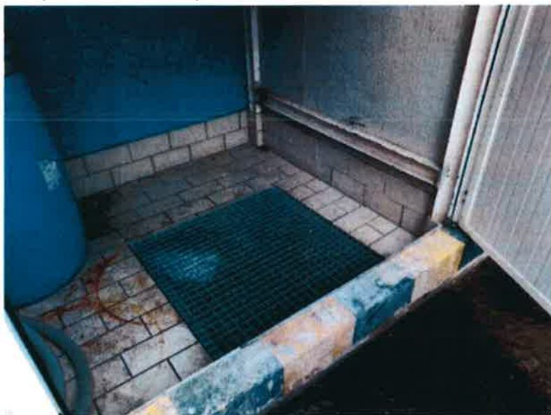
Figura 1 – Construção de nova bacia de contenção estanque no reservatório de óleos com revestimento a mosaico anti-ácido.
